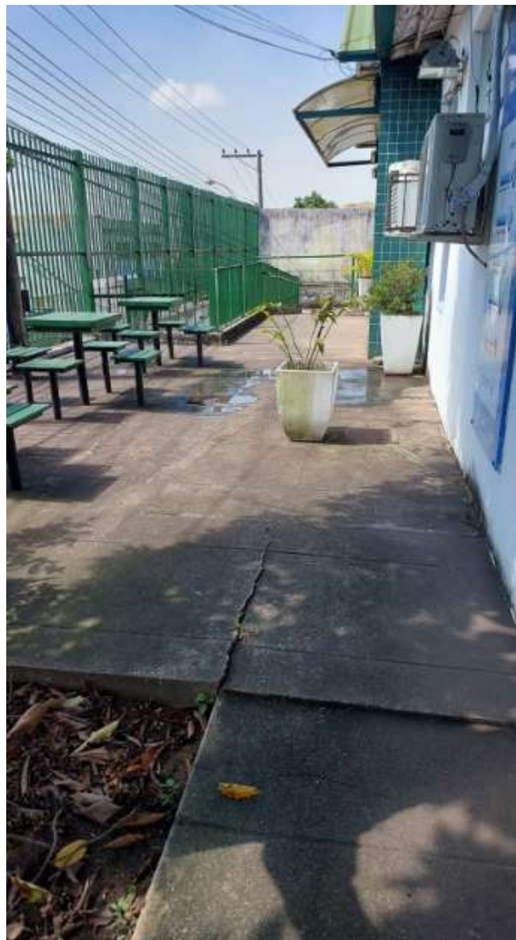
Piso do “pátio” a regularizar
