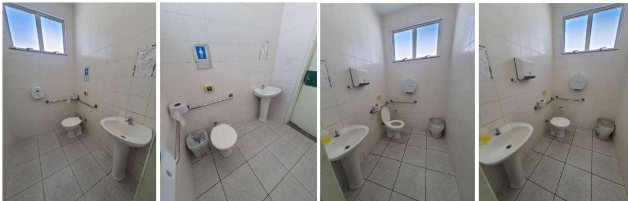
Sanitários acessíveis existentes apresentado em laudo
