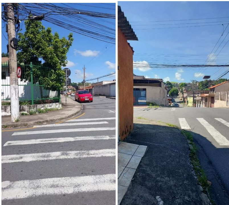
Calçadas sem rebaixamento para acesso à faixa de pedestre
