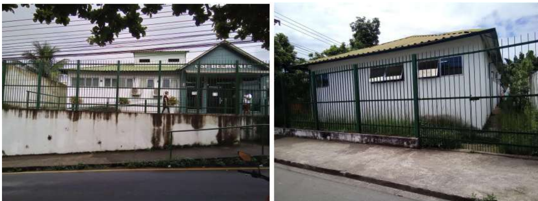
Muro e cordão de concreto existentes.
