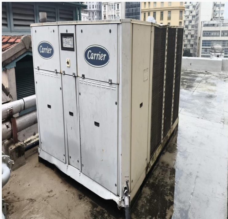
Chillers Condensação a ar 01
