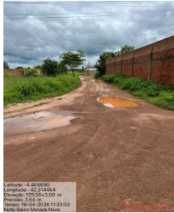
Foto N° 12- RUA PROJETADA 02 MORADA NOVA
