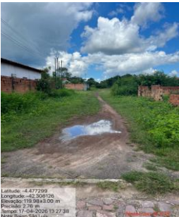
Foto N° 07- RUA PROJETADA BAIRRO SÃO LUIS
