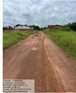
Foto N° 13- RUA PROJETADA 02 MORADA NOVA
