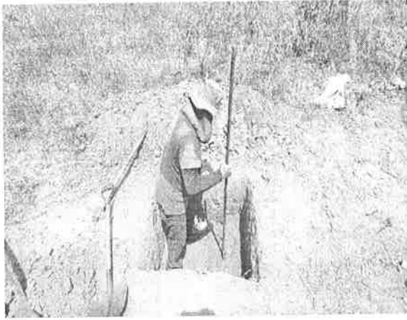
Foto 05 - Detalhe da abertura da vala para dar início ao Ensaio de Absorção do terreno.
