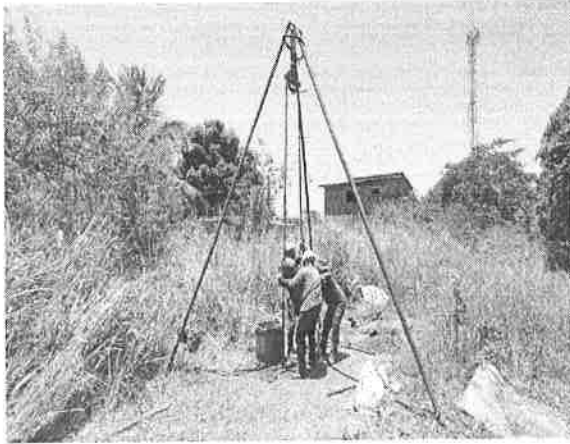
Foto 01 - Detalhe da operação de cravação do amostrador padrão para obtenção do "SPT" do terreno de fundação.
