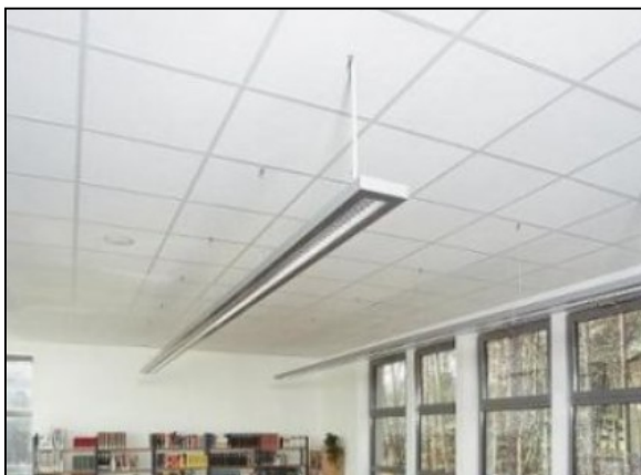
Foto 1 - Visão geral das placas de forro instaladas
