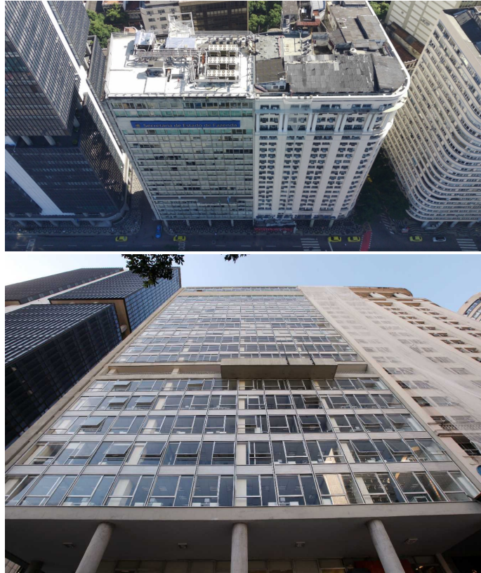
Figuras 1 e 2: atual sede da Secretaria de Estado de Fazenda do Rio de Janeiro, situada à Av. Presidente Vargas, nº 670 - Centro, Rio de Janeiro/RJ, objeto da contratação sobre a qual versa este documento. Acima, tomada aérea; abaixo, fachada principal a partir do ponto de vista do pedestre. Fonte: (respectivamente) arquivo da rede interna COOEAR/SUPEPAT/SEFAZ, foto de 2023; site da SEFAZ ; acesso em 25/10/2023.
