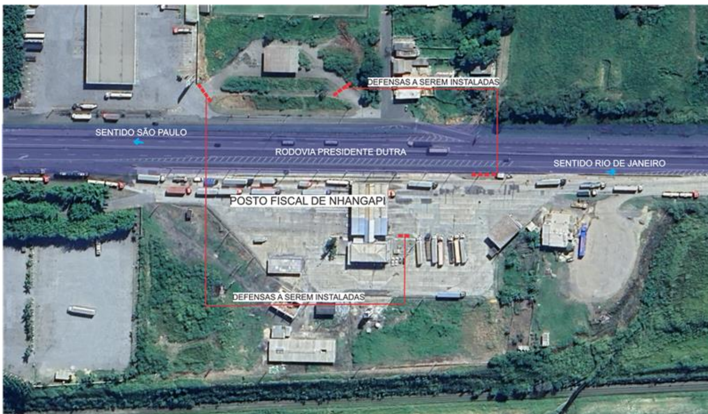
Figura 2: Vista aérea do PCF 01 de Nhangapi com área de alocação das defensas. Fonte: Google Earth
