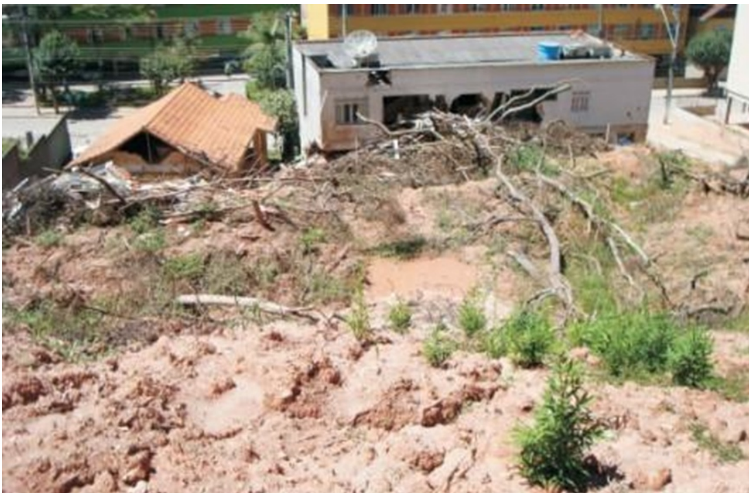
Figura 06: Fotografia de localidade em Vila Nova, após o incidente de 2011 (Fonte: CPRM)
