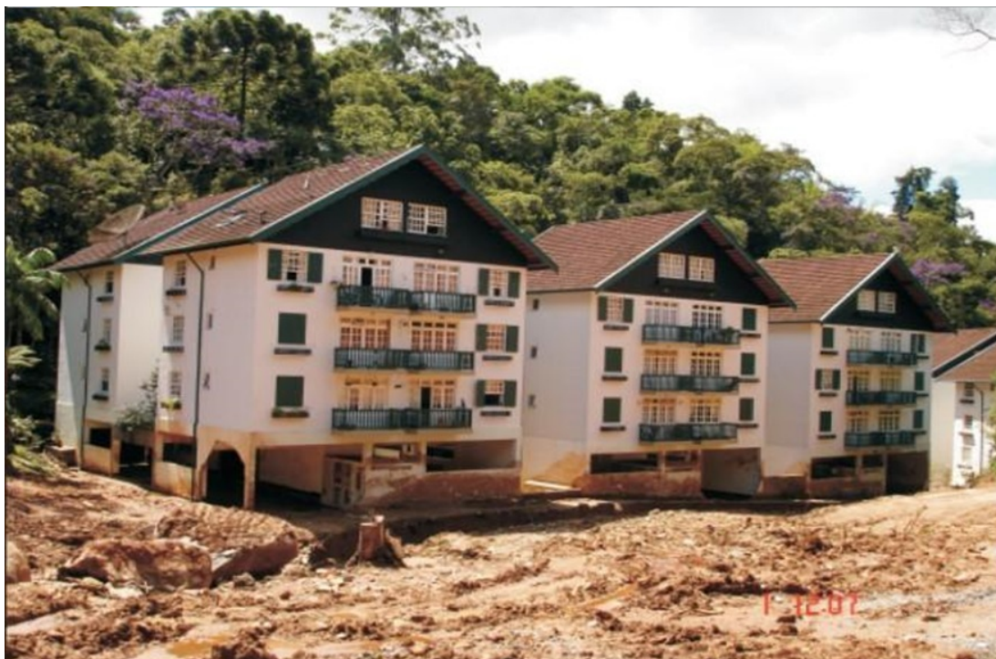
Figura 16: Fotografia de localidade em Vila Nova, após o incidente de 2011 (Fonte: CPRM)
