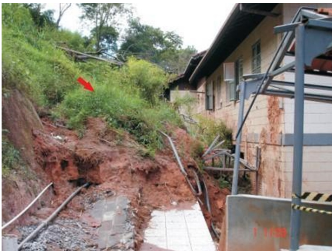
Figura 13: Fotografia de localidade em Vila Nova, após o incidente de 2011 (Fonte: CPRM)
