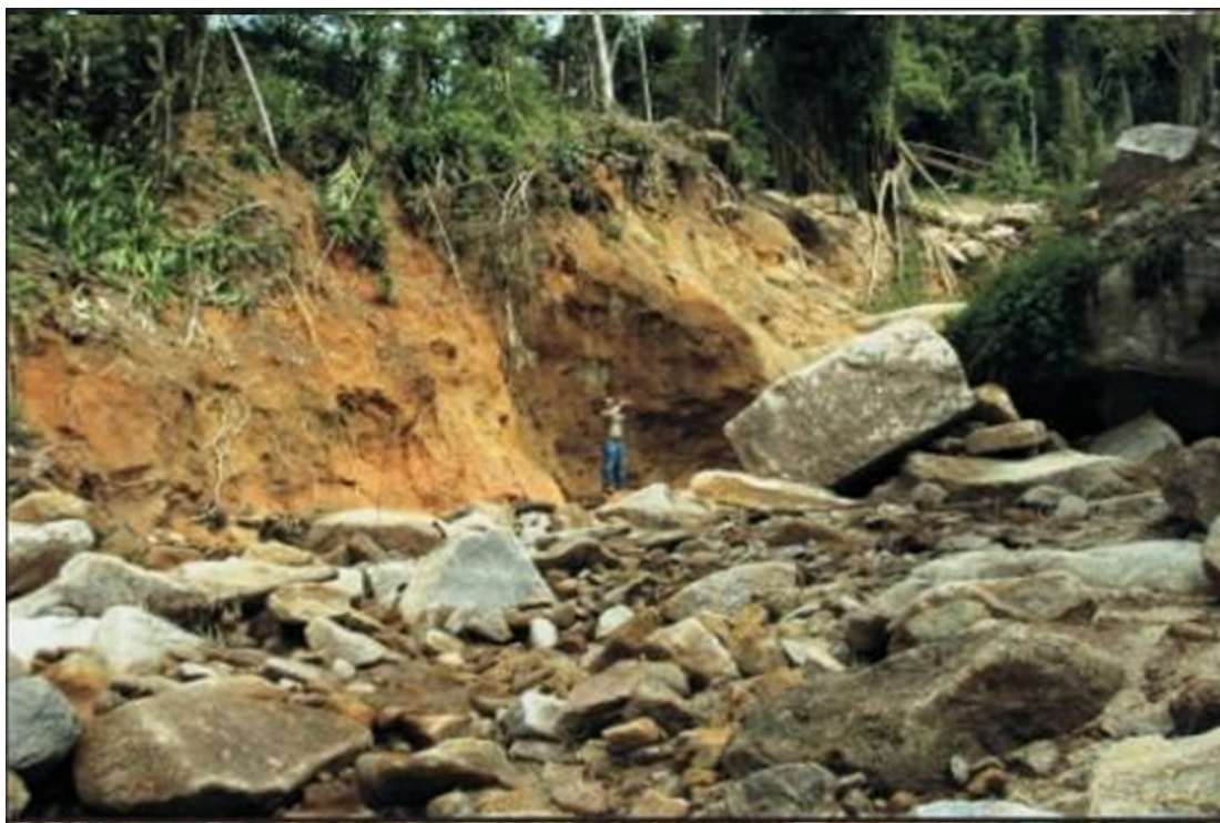
Figura 10: Fotografia de localidade em Vila Nova, após o incidente de 2011 (Fonte: CPRM)
