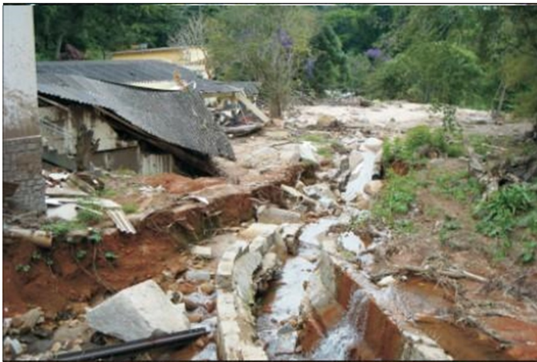
Figura 11: Fotografia de localidade em Vila Nova, após o incidente de 2011 (Fonte: CPRM)
