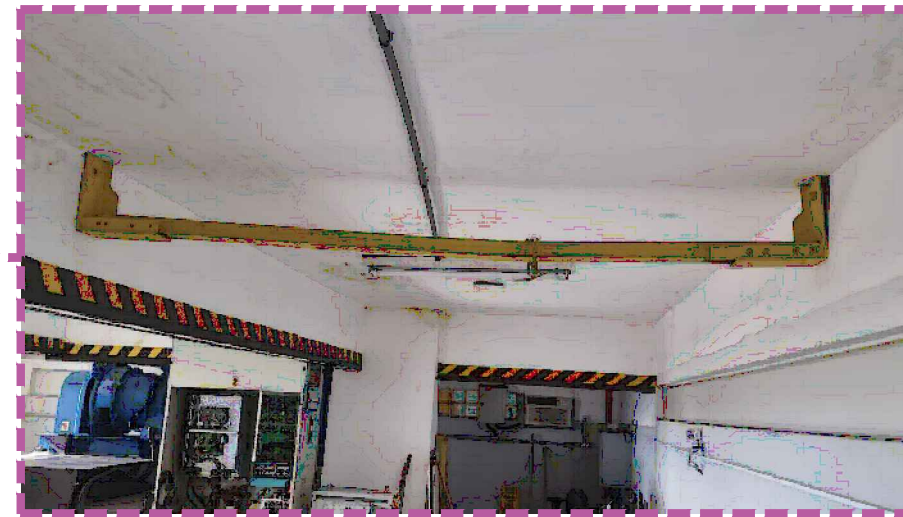
VIGA PARA IÇAMENTO
