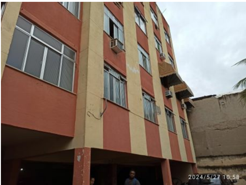
Figura 01: Fachada Edifício Rogério
