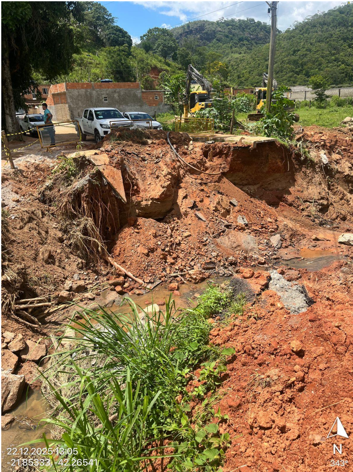
Imagem 2 – Evento estrangulamento da seção causado pela chuva – BOA SORTE/CANTAGALO
