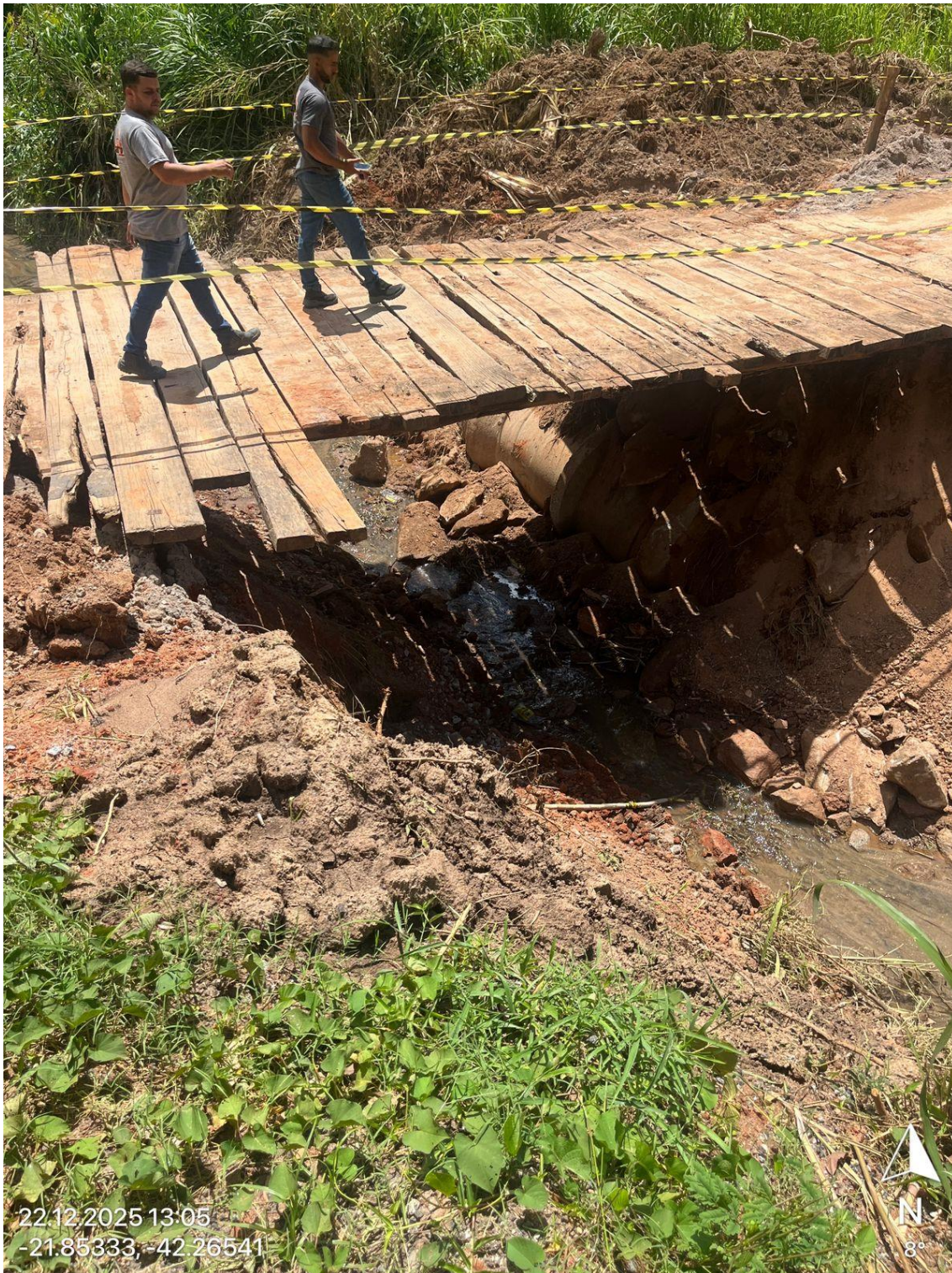
Imagem 3 – Evento estrangulamento da seção causado pela chuva – BOA SORTE/CANTAGALO
