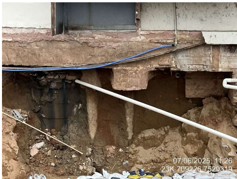
Figura 5 – Visualização da fundação profunda em estacas e de elementos do sistema sanitário existente, como possível fossa e tubulações expostas.
