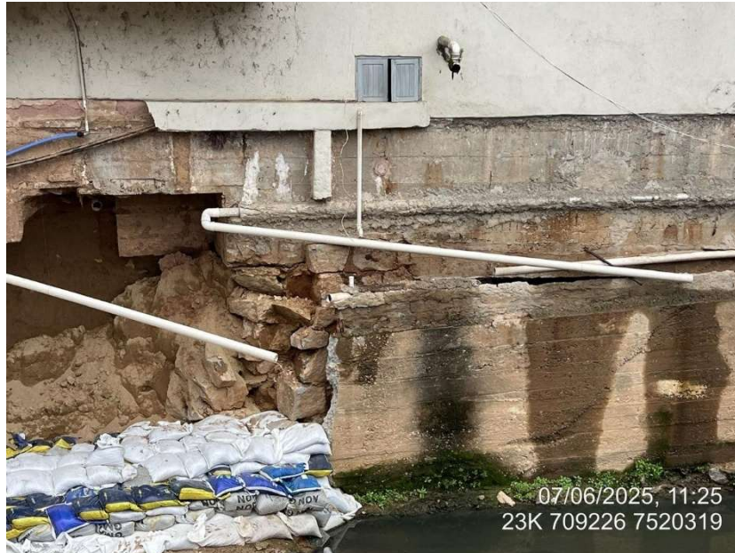
Figura 6 – Trecho remanescente do muro lateral, apresentando deslocamentos e sinais de instabilidade estrutural.
