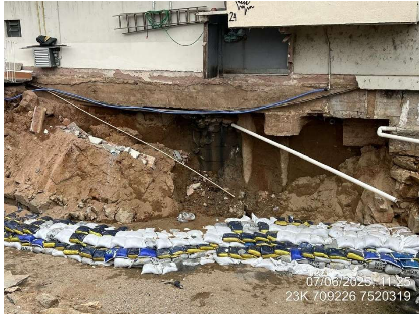
Figura 4 – Detalhe do trecho rompido do muro de alvenaria de pedra argamassada, situado na parte posterior do Edifício Granado.
