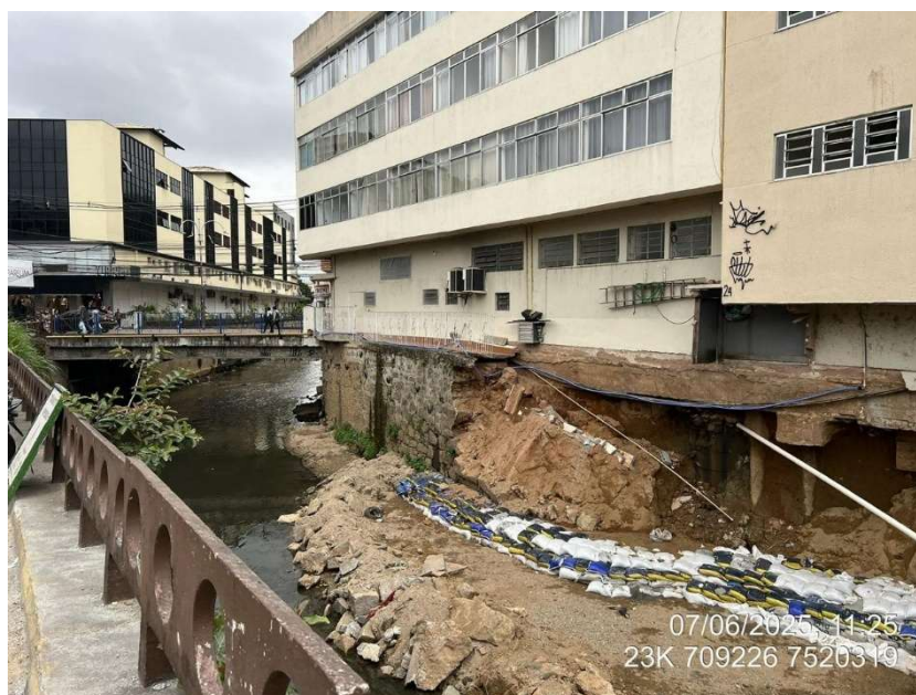
Figura 3 - Perspectiva complementar da intervenção provisória na margem colapsada, evidenciando a ocupação parcial do leito por enrocamento.
