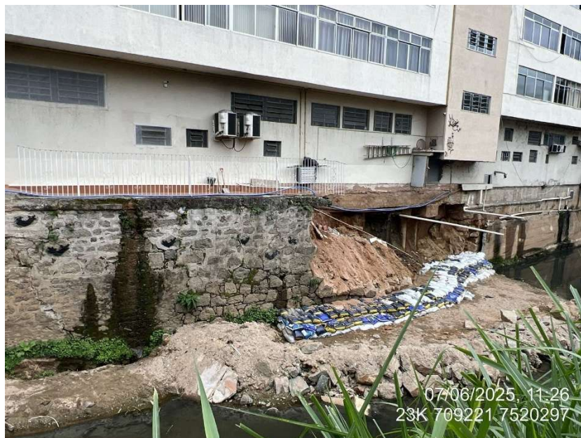
Figura 2 - Vista geral da ruptura nos fundos do Edifício Granado, com destaque para a intervenção emergencial executada com aterro e aplicação de Rip-Rap.
