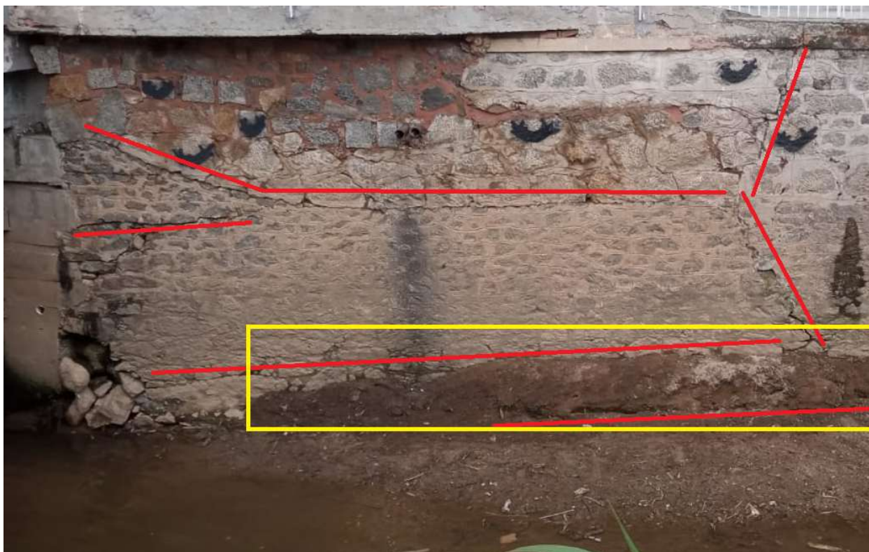
Figura 5 – Imagem registrada em abril pelos administradores do edifício antes do rompimento, linhas vermelhas indicam fraturas visíveis com aberturas em centímetros no muro e zonas em amarelo, sinais de saturação do solo com presença de umidade.
