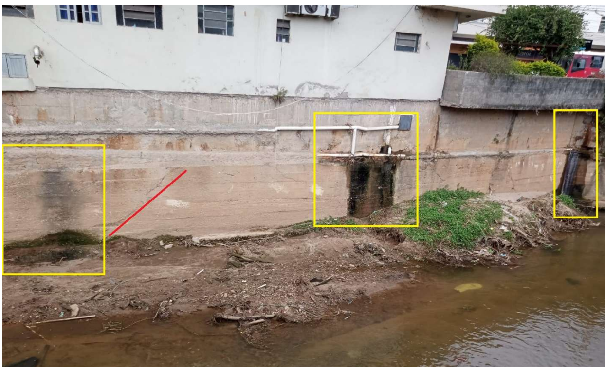
Figura 7 – Imagem registrada em abril pelos administradores do edifício antes do rompimento, linhas vermelhas indicam fraturas visíveis com aberturas em centímetros no muro e zonas em amarelo, sinais de saturação do solo com presença de umidade.
