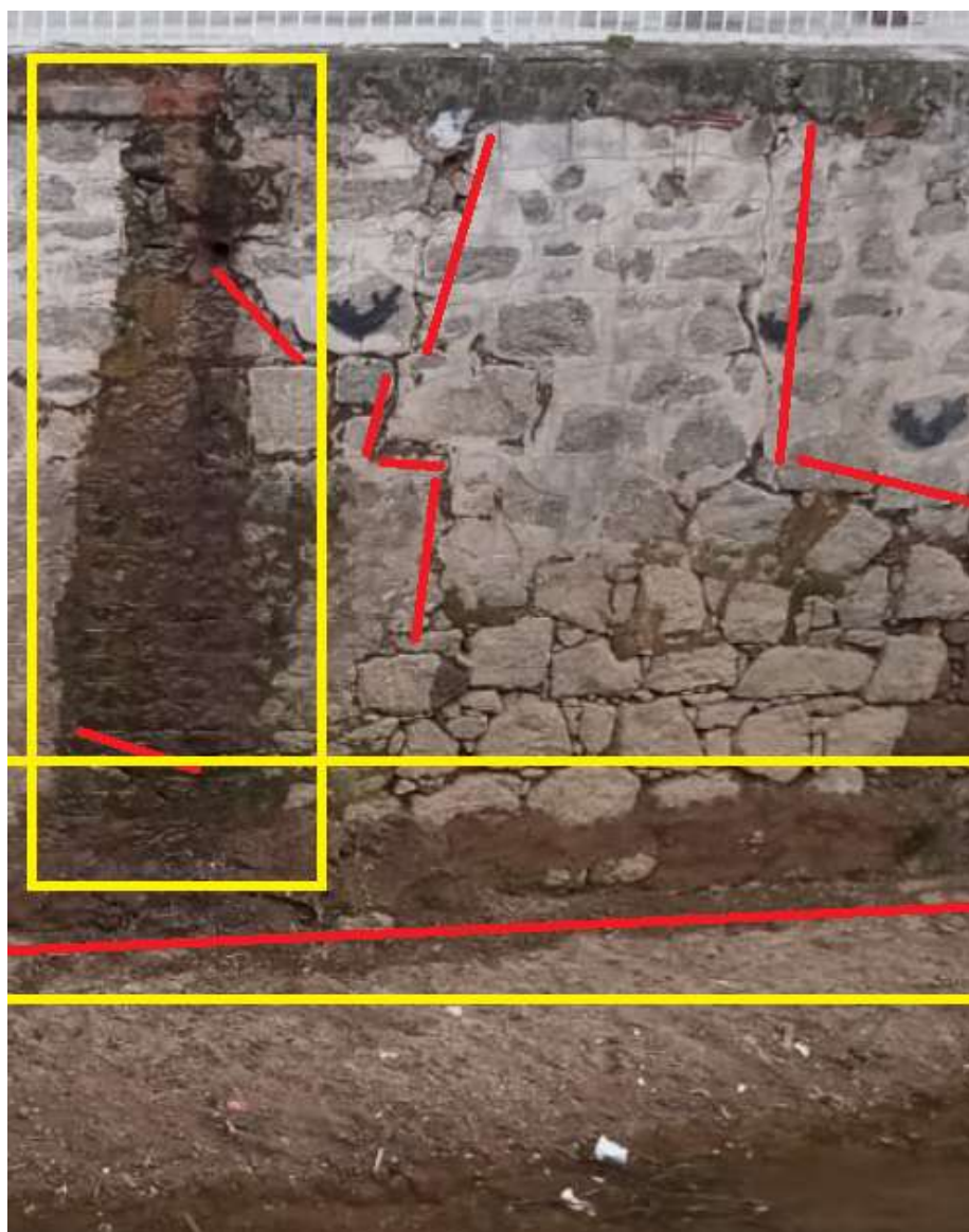
Figura 6 – Imagem registrada em abril pelos administradores do edifício antes do rompimento, linhas vermelhas indicam fraturas visíveis com aberturas em centímetros no muro e zonas em amarelo, sinais de saturação do solo com presença de umidade.
