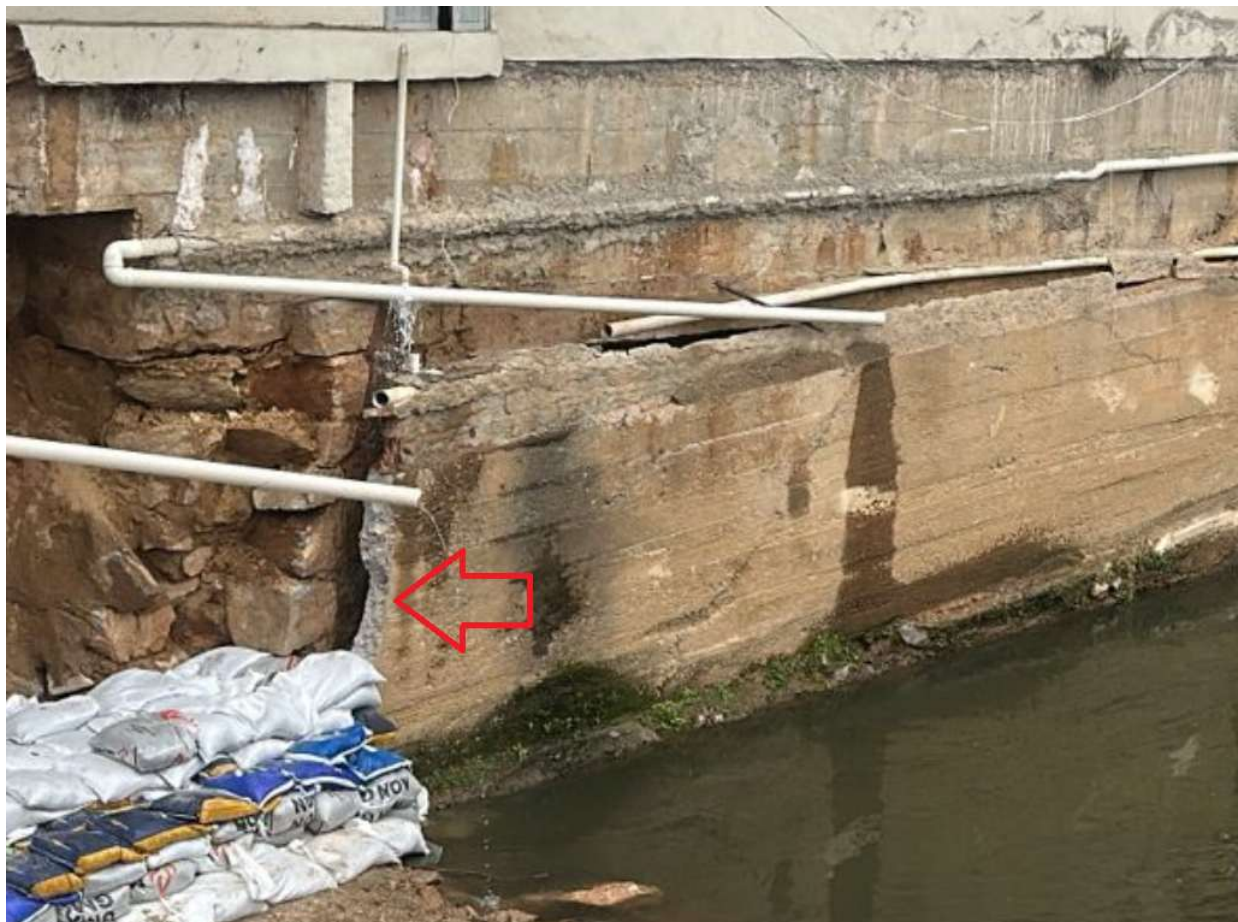
Figura 9 – Trecho em concreto, aparentemente sem armadura, possuindo função secundária de reforço superficial e fechamento dos vazios entre os blocos de pedra do muro.
