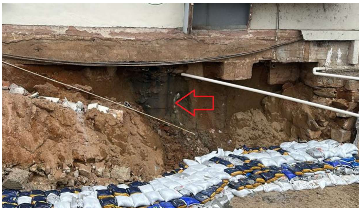
Figura 2 – Indicação da fossa do prédio em seta vermelha, exposta após rompimento do muro
