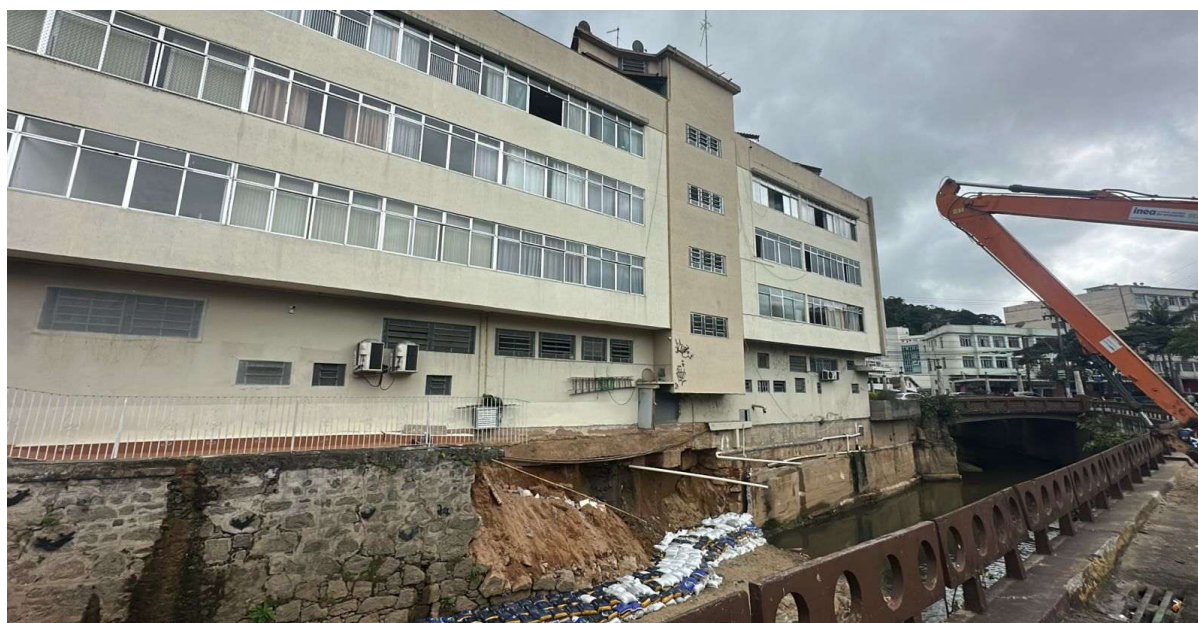
Figura 1 – Imagem registrada em 27/05/25 após o rompimento do muro junto à edificação.
