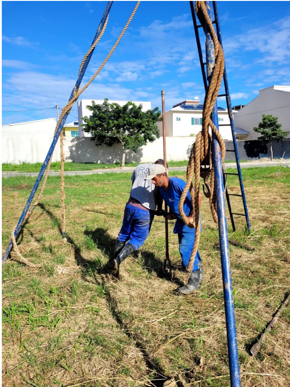
Figura 3 – Execução da Sondagem SPT.
