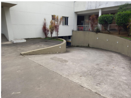
01 - Vista das cisternas a serem higienizadas. À esquerda fica a de água potável e à direita fica a de reuso das águas pluviais.
