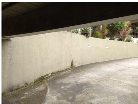
04 – Vista da cisterna de água de reuso pelo subsolo.
