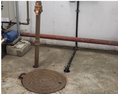
9 – Poço de coleta de águas servidas da garagem
