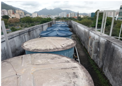
10 – Vista geral das caixas de água na cobertura do Clube. As quatro mais próximas são de água potável. As duas seguintes são de responsabilidade da Academia SmartFit e não fazem parte da caixas a serem higienizadas. As duas últimas são de reuso e também serão higienizadas. Sendo assim, as caixas a serem higienizadas na cobertura são seis, cada uma com 1.500 litros, fazendo um total de 9.000 litros.
