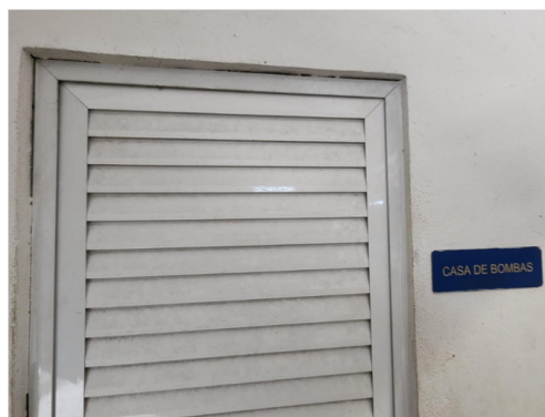
8 - Acesso ao poço de coleta de águas servidas da garagem
