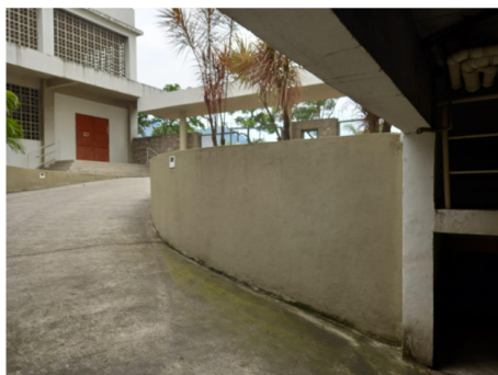
03 – Vista da cisterna de água potável pelo subsolo.
