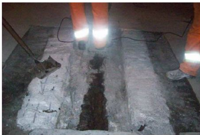
Foto 2: Corte de uma faixa de 50 cm adjacente ao berço de concreto.
