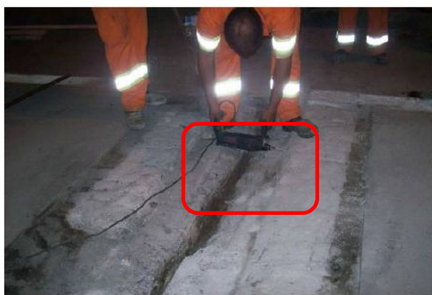
Foto 5: Furação na lateral da estrutura para chumbar os grampos.
