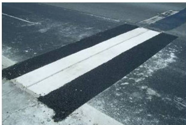
Foto 13: Pavimentação nas duas laterais do berço.
