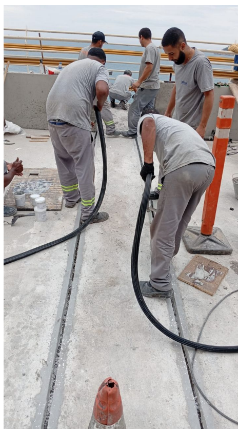
Foto 15: Aplicação do perfil elastomérico.
