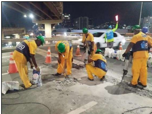
Retirada do berço existente
