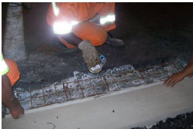
Foto 7: Colocação de adesivo epóxi para aderência do novo concreto.
