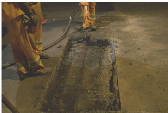
Foto 1: Retirada do berço existente.
