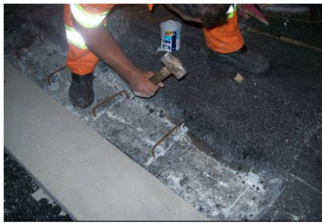
Foto 4: Nivelamento dos grampos.
