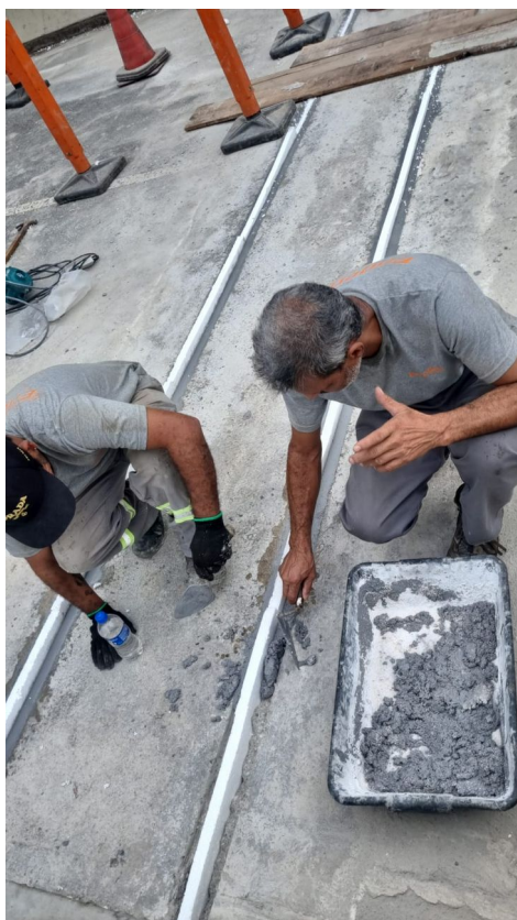
Foto 14: Execução dos lábios poliméricos.
