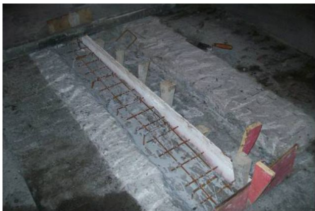
Foto 8: Local preparado para concretagem.
