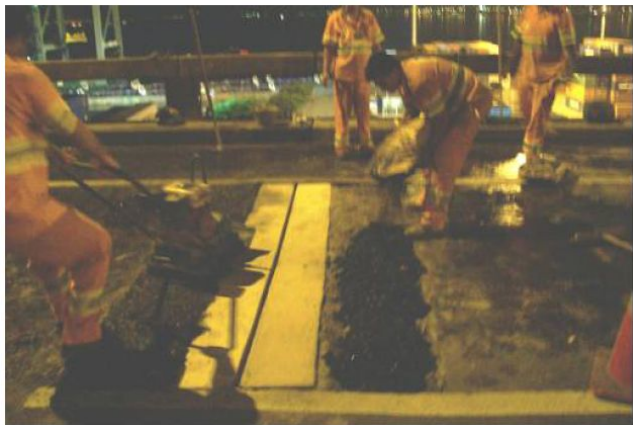
Foto 11: Aplicação do pavimento asfáltico para nivelar a entrada no berço.
