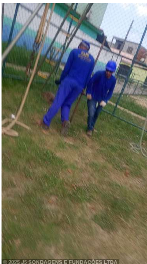
© 2025 J5 SONDAGENS E FUNDACOES LTDA Foto 1 – Relatório Fotográfico das Atividades - Execução de Sondagem a Percussão
