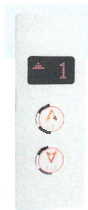
Figura 06: Painel de pavimento do lado de cada elevador
