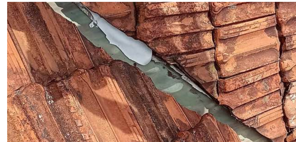
Foto 51: Sobras da subcobertura (lona/ tyvek) expostas às intempéries, causando fragilidade no suporte e diminuição da sua vida útil.
