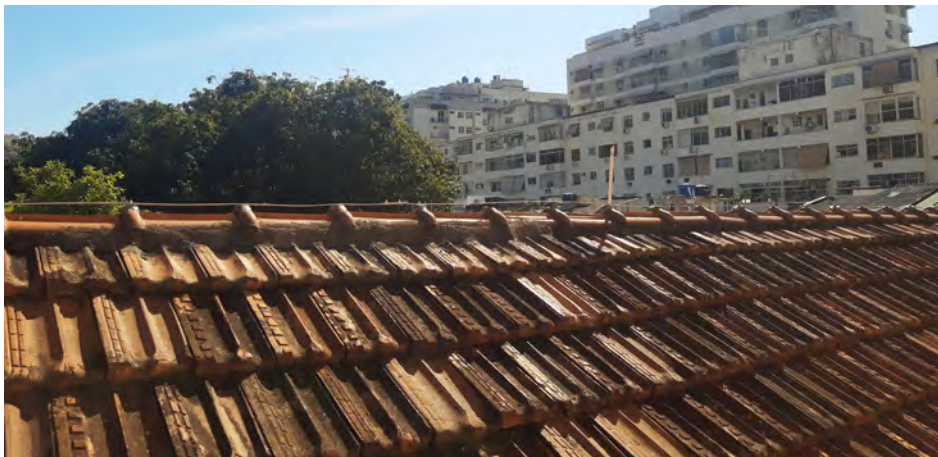
Foto 39: Cumeeira apresentando excesso de argamassa para fixação e telhas com sujidades.
