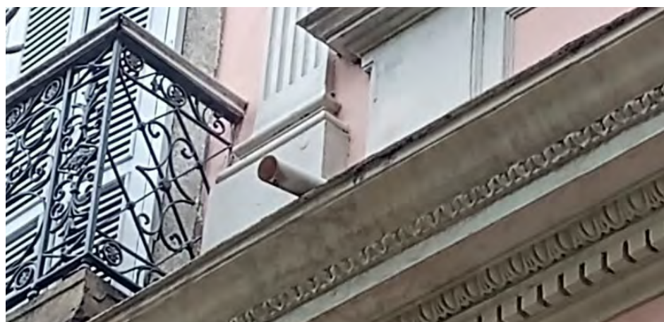
Foto 62: O buzinote de cobre foi substituído por um cano de PVC.
