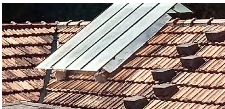
Foto 47: Vista distanciada da clarabóia, passadiços e encontro com o telhado TE 04.
