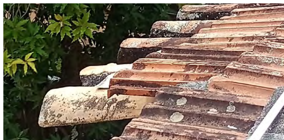
Foto 54: Telhas do beiral da sala João Barbosa com sujidades e com pedaços faltantes, além de visivelmente estarem com uma inclinação mais baixa do que a indicada, demonstrando que estas telhas podem estar afundando.
