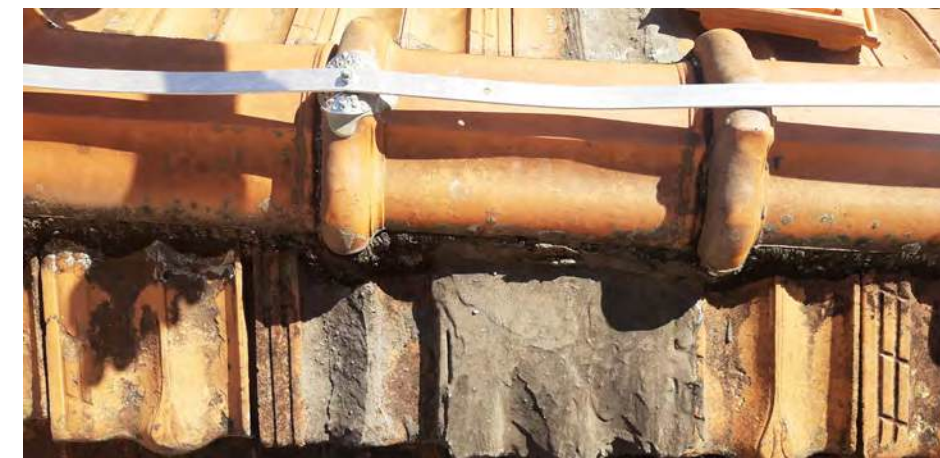
Foto 43: Manta impermeabilizante aplicada em trechos de telhas próximas a cumeeira.
