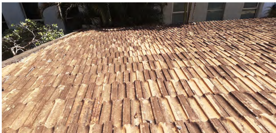
Foto 146: Continuidade do trecho da foto anterior, apresentando telhas também com sujeiras e vão entre peças após substituição por modelos com sutis diferenças nas dimensões.
