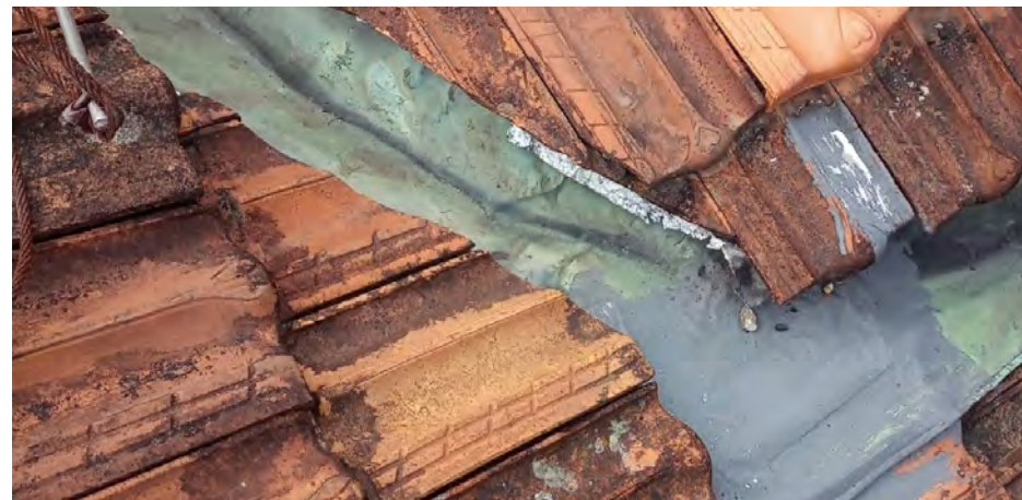
Foto 50: Manta impermeabilizante aplicada no rincão do telhado.
