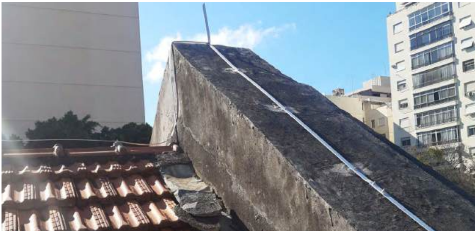
Foto 04: Frontão com sistema SPDA recém instalado, apresentando danos similares ao citado na foto 1, porém ao invés da presença do rufo metálico há a aplicação de manta impermeabilizante e argamassa, ambas em estado de deterioração.
