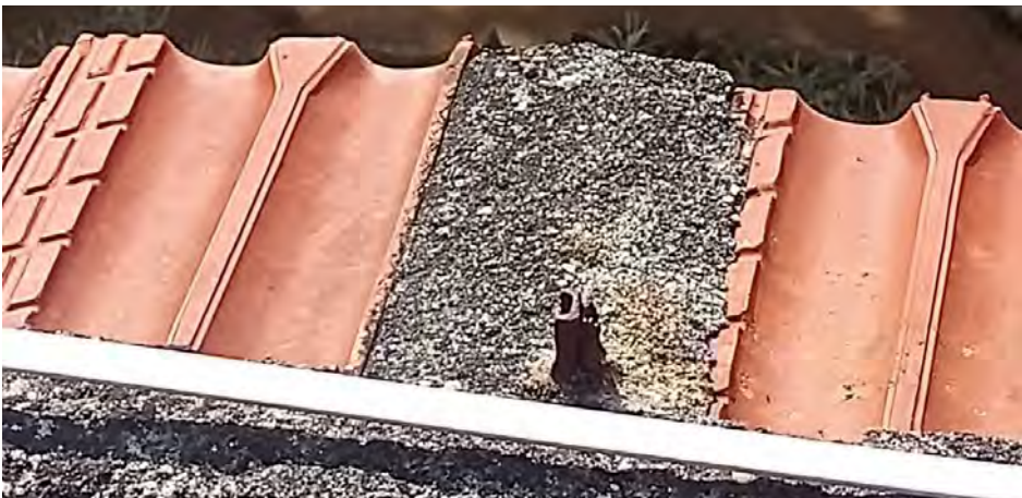
Foto 24: Telha faltante foi preenchida com argamassa. Resquícios de instalação anterior de SPDA que não foi completamente removida.
