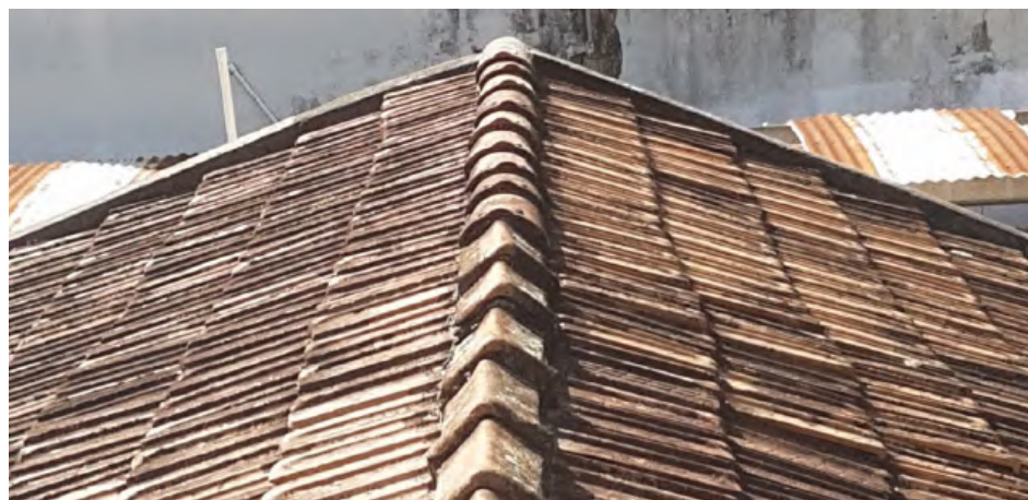
Foto 144: Cumeeira com telhas diferenciadas em modelo e formato.
