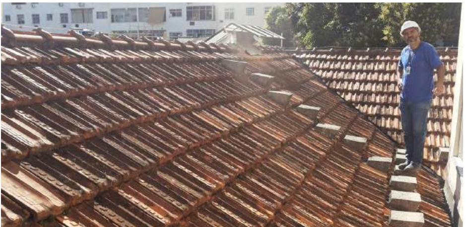
Foto 40: Itens apontados na foto anterior e vista da clarabóia e encontro com o telhado TE 04.
