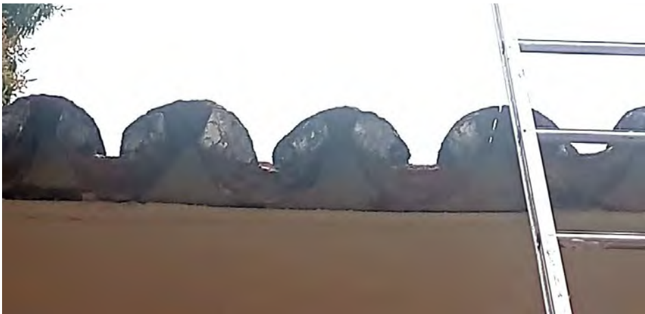
Foto 102: Telhas com falhas na argamassa de assentamento. A deisntegração da argamassa apresenta riscos de desprendimento e prejudica também as telhas que podem fissurar e ficar mais fragilizadas.
