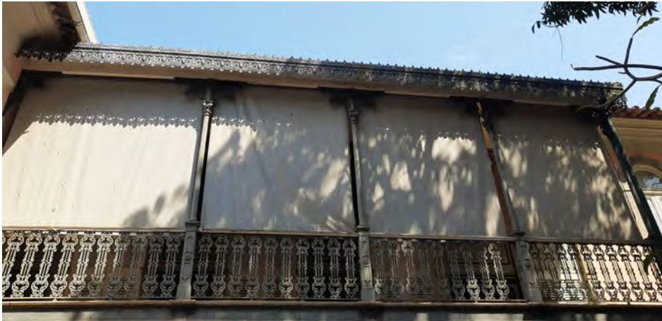
Foto 88: Vista geral da varanda à partir do nível térreo.
