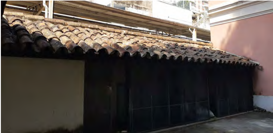
Foto 123: Vista geral da área do antigo canil, após remoção de vegetação presente em fotos seguintes.
