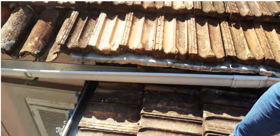
Foto 91: Trecho adjacente ao telhado TE06, mencionado na foto 89. Observa-se a calha em pvc tortuosa e sobreposta pela cobertura, direcionando o escoamento da água para fora.
