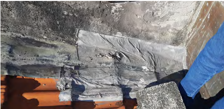
Foto 05: Lateral de encontro entre frontão, saia de cobre da platibanda e cobertura em telhas francesas, com aplicação de manta impermeabilizante entre as superfícies.
