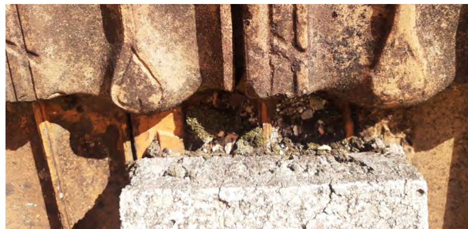
Foto 42: Presença de vegetação nas arestas superiores dos passadiços próximos ao sobrado.
