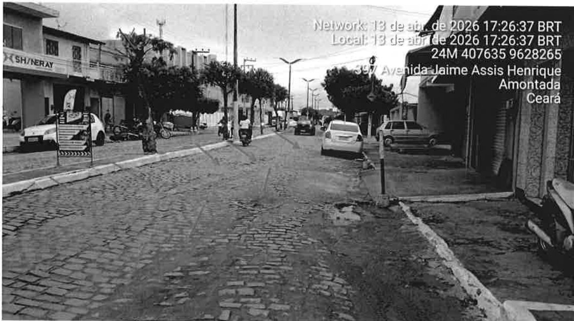
AMOSTRA VISUAL - PAVIMENTAÇÃO EXISTENTE D AVENIDA JAIME ASSIS HENRIQUE – VIA DE GRANDE TRÁFEGO SENDO A PRINCIPAL ENTRADA E SAÍDA DA SEDE DO MUNICÍPIO – COM DEFORMAÇÕES DO PAVIMENTO DEVIDO À FRAGILIDADE DO SUBLEITO.
