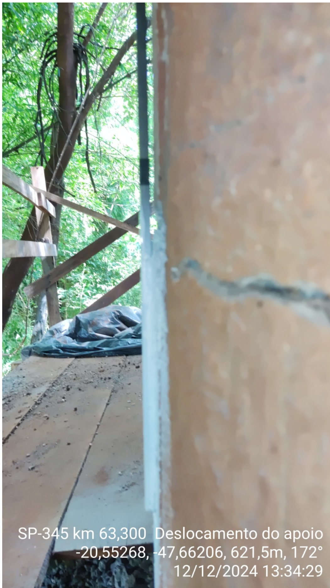
Foto 3 – Pilar P7 com sinal de deslocamento na trinca.
