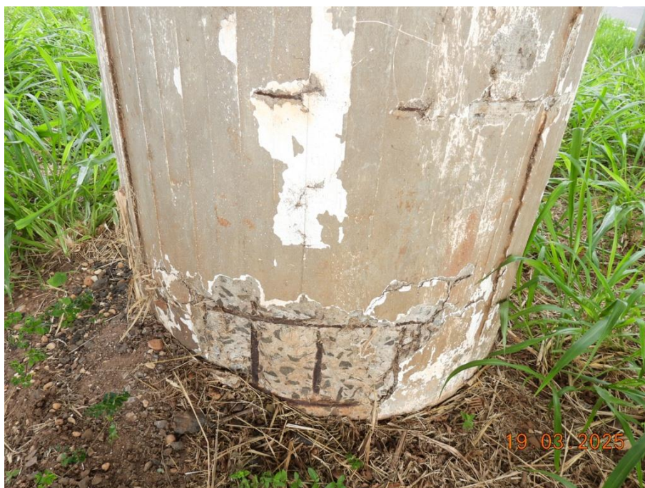
Foto 32. Concreto disgregado com armaduras expostas oxidadas no pilar.
