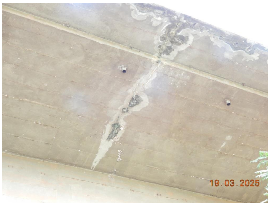
Foto 31. Fissura com eflorescência em balanço de laje.
