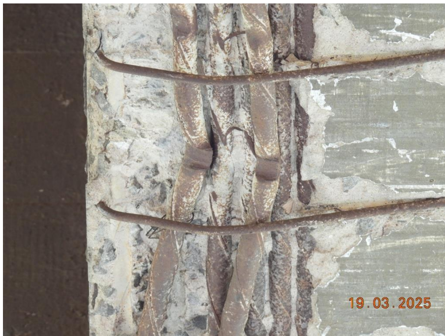
Foto 13. Detalhe da foto anterior. Perda de seção em duas barras longitudinais da VL2.
