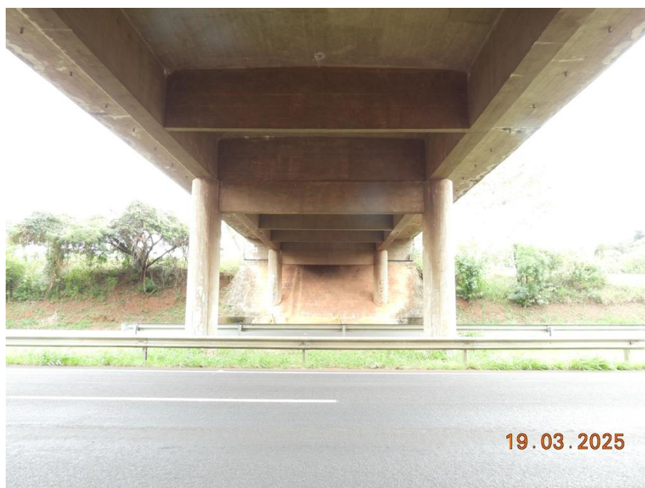
Foto 4. Apoio central, protegidos por defensas metálicas, e apoio 1.
