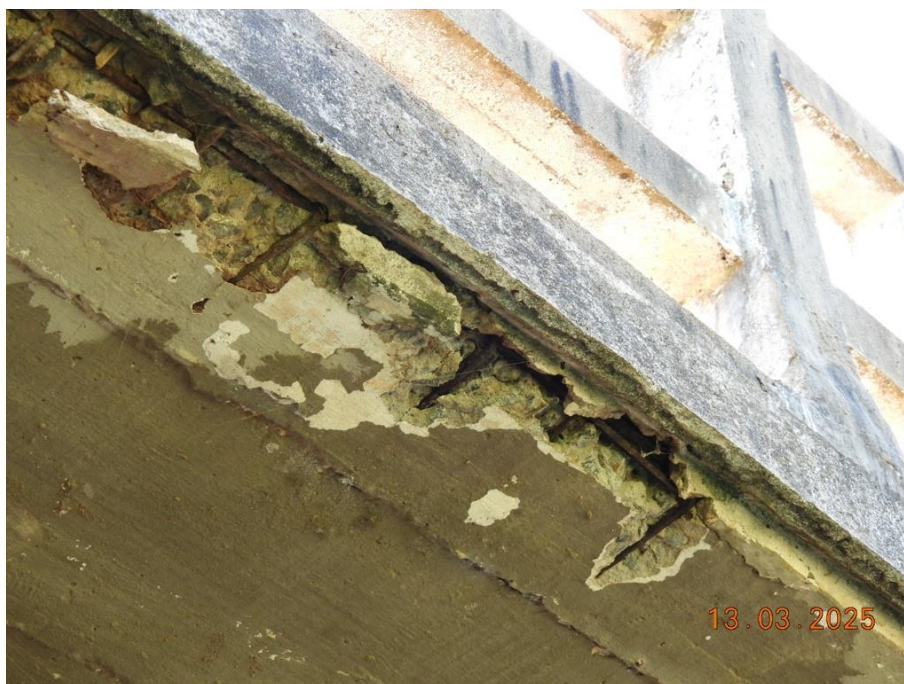
Foto 30. Concreto disgregado com armaduras expostas e oxidadas na face inferior do balanço de laje.
