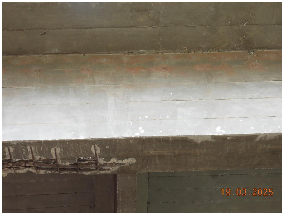
Foto 17. Fissura de 0,2mm na VL2, próxima a região de impacto.
