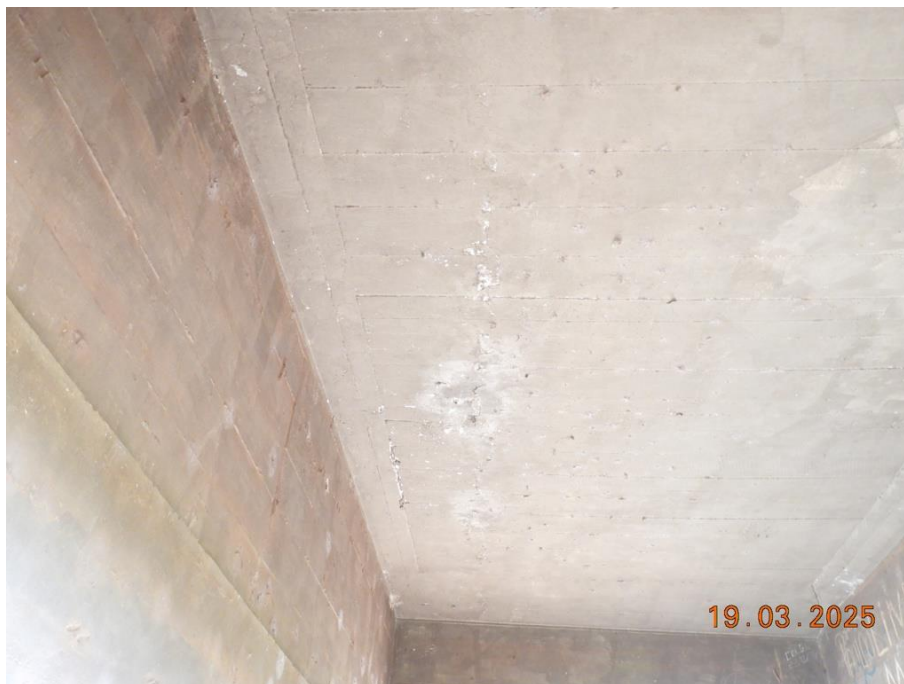
Foto 29. Fissura com eflorescência em painel de laje.
