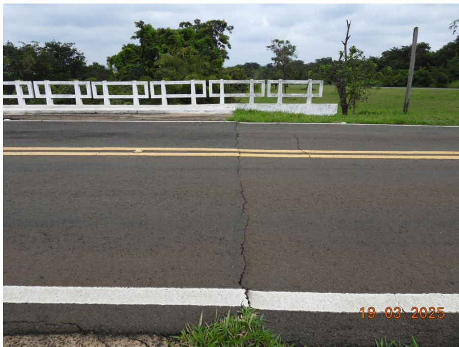
Foto 27. Trinca e desnível no pavimento do encontro.
