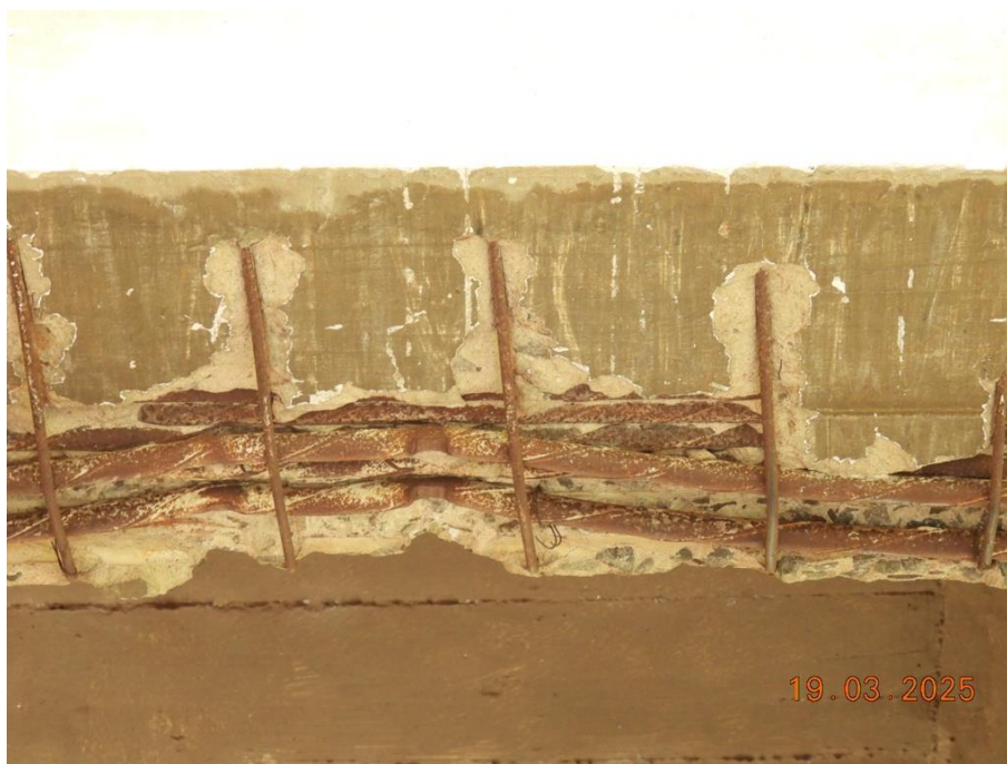
Foto 9. Detalhe da foto anterior. A VL2 tem duas barras longitudinais deformadas e com perda de 50% de seção.
