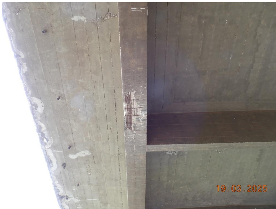
Foto 25. Vista inferior da VL1 na área de impacto.
