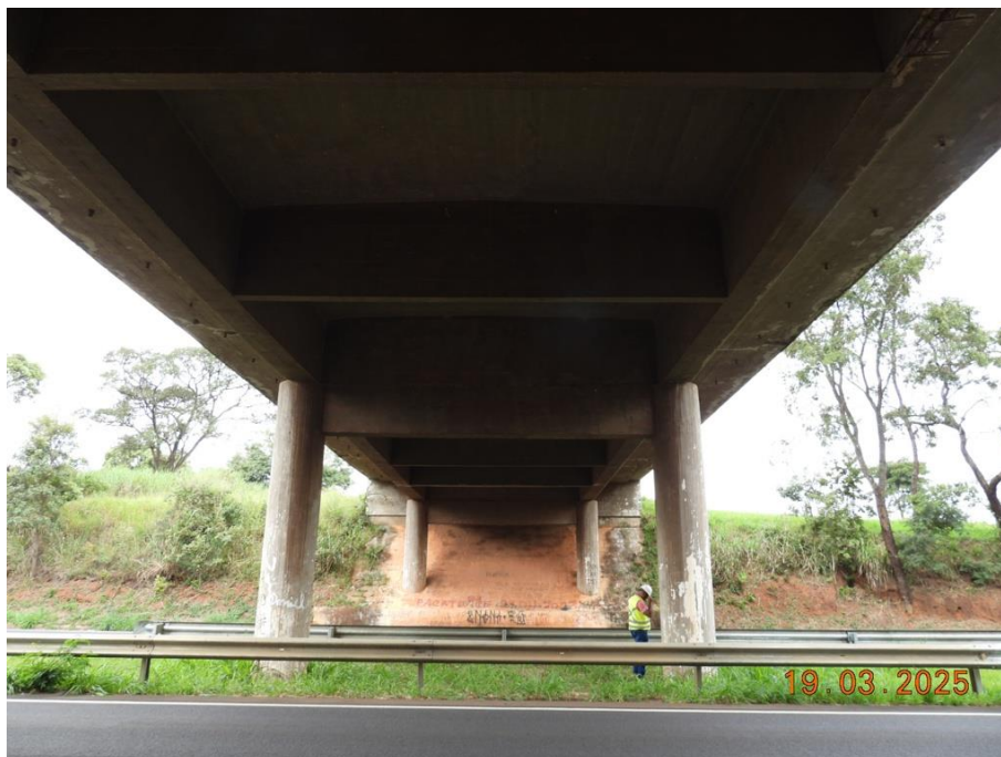
Foto 5. Apoio central, protegidos por defensas metálicas, e apoio 3.
