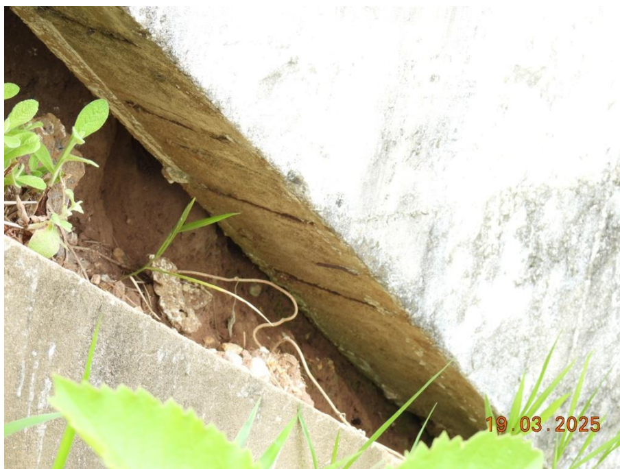
Foto 28. Concreto disgregado com armadura exposta oxidada na ala. Fuga de material do encontro.
