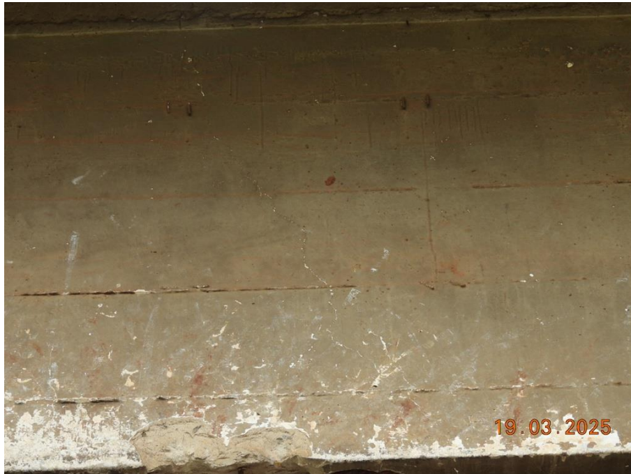
Foto 20. Fissura de 0,2mm acima da área de impacto da VL1, face leste.
