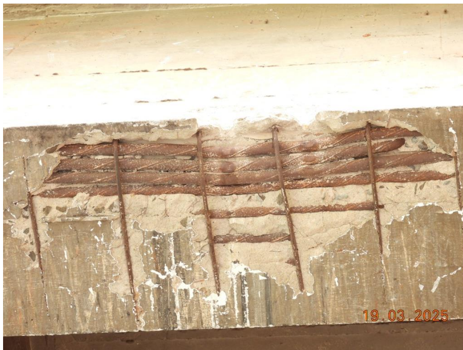
Foto 23. A VL1 encontra-se com 3 barras deformadas, com perda de seção \leq 10\% .
