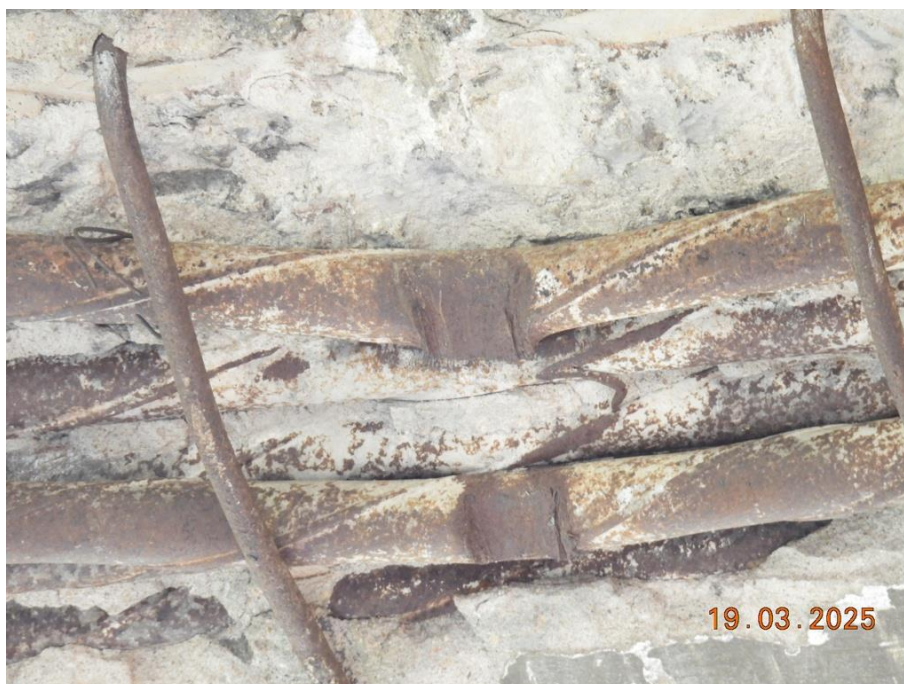
Foto 16. Detalhe da foto anterior, com a perda de seção nas duas barras longitudinais.
