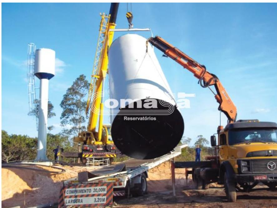
**SOMENTE após o içamento e o patolamento do guindaste, a estrutura da caixa d'água será desparafusada das barras roscadas que a seguram ao bloco de coroamento.**
