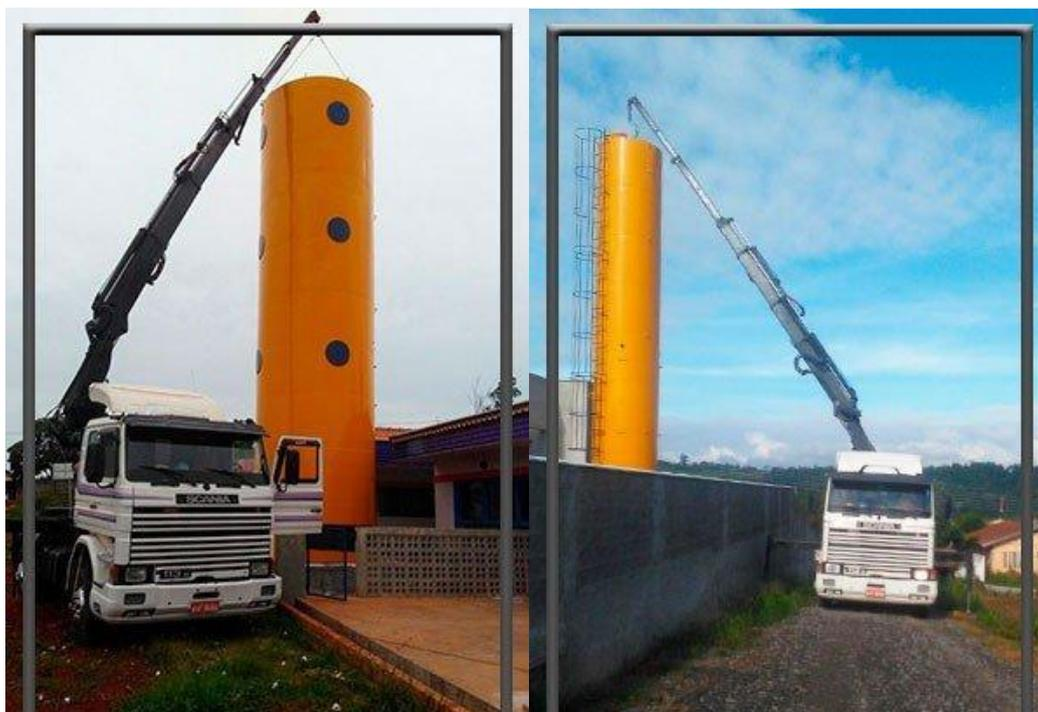
Conforme modelo demonstrado no anexo deste TR, **a atual caixa d'água é do tipo metálica tubular alta, com capacidade total de 45 mil litros de água, sendo 10,80m de altura e 2,86m de diâmetro. A Caixa é do tipo FNDE 45 CASTELO.**
