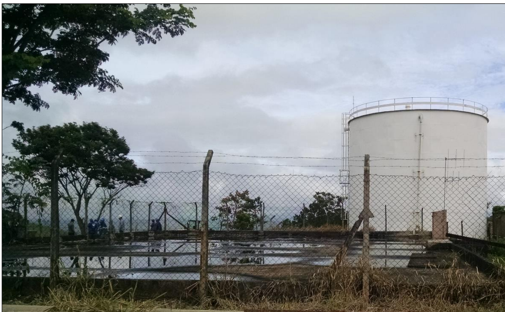
Figura 3 - Reservatórios Basílica enterrado e elevado (Fonte: autor)
