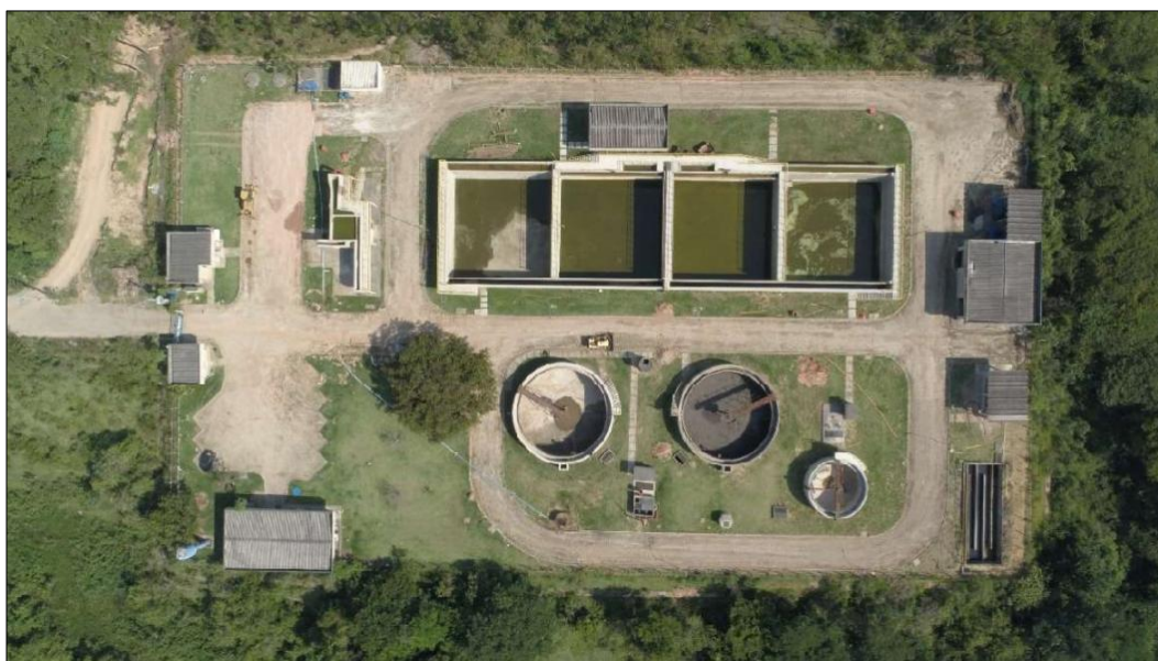
Figura 1 - Vista aérea da ETE (Fonte: SAAE, 2023)
