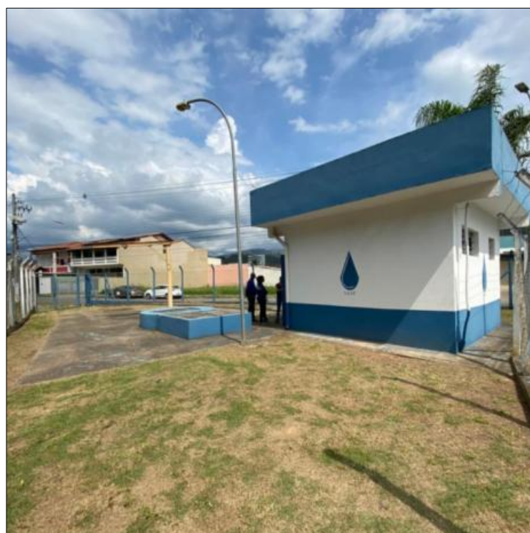
Figura 13 - EEE Jardim Paraíba inoperante por cota superior à rede coletora
