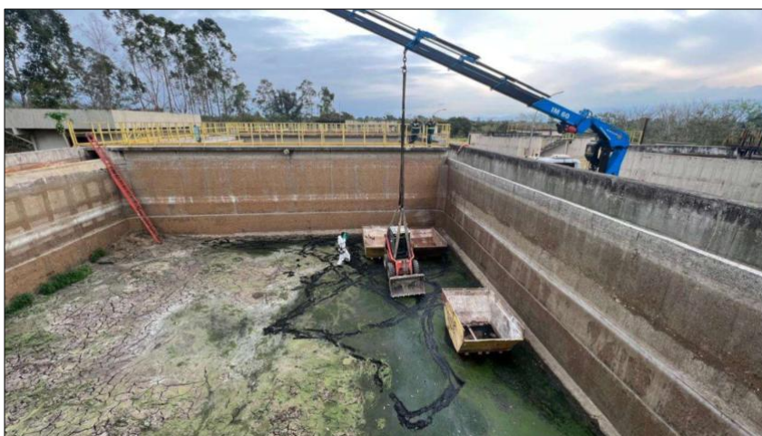
Figura 4 - Vista de um dos reatores (tratamento biológico) em processo de limpeza recente
