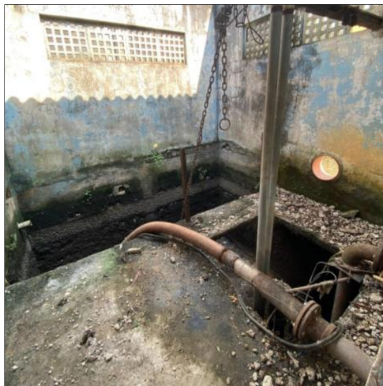
Figura 17 - EEE Vila Mariana com instalações precárias, efetuando despejo irregular
