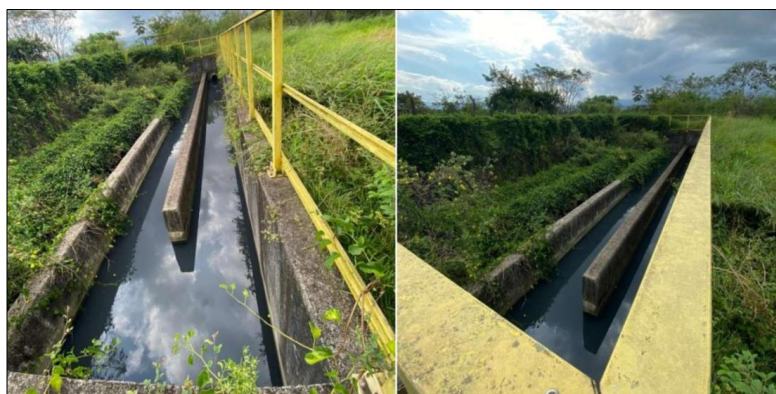
Figura 9 – Chicana de desinfecção do efluente
