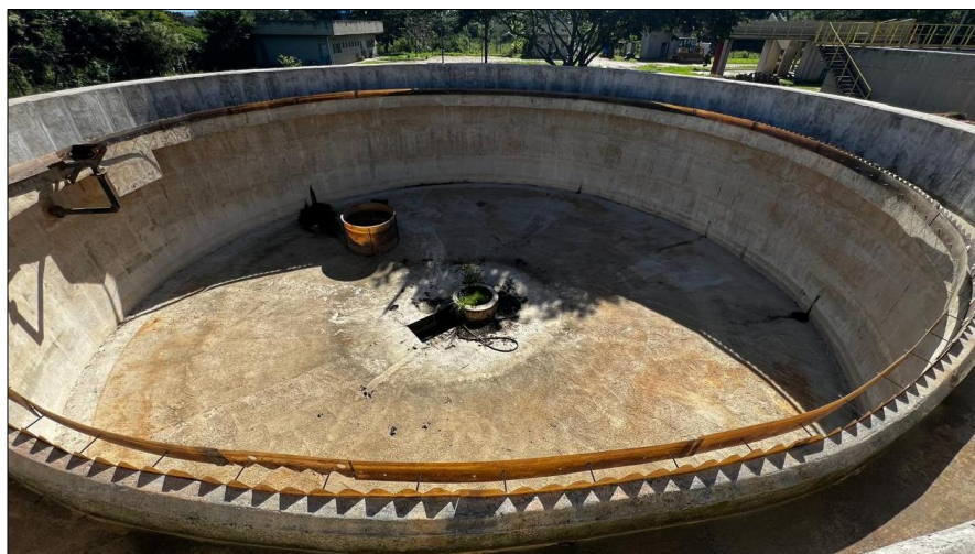
Figura 6 - Decantador secundário após limpeza recente
