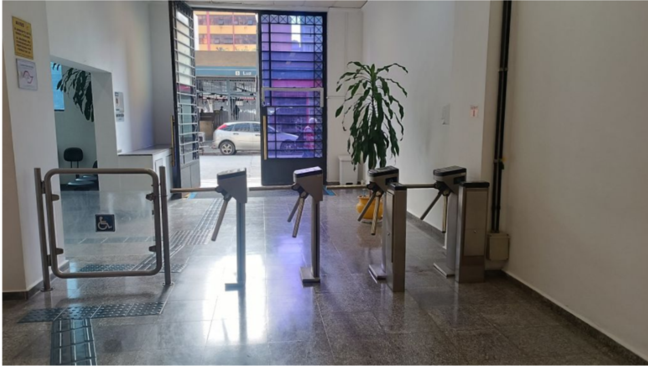
Fig.01 - Catracas do acesso principal
