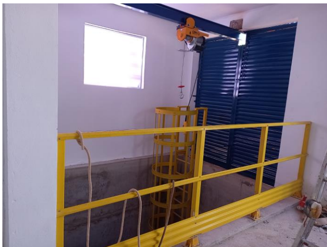
Foto ilustrativa do guarda corpo, monovia, talha, trole, escada com guarda corpo
