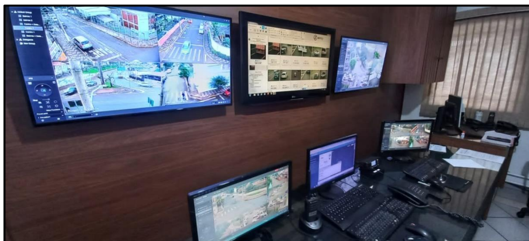
Foto 01: Centro de Operação da Central de Monitoramento, na sede da Guarda Civil Municipal.
