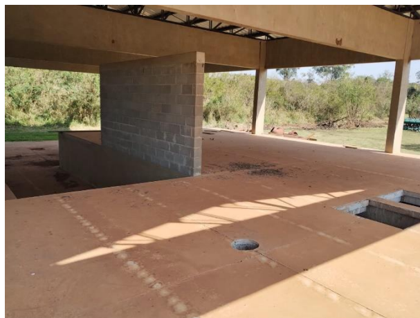
Figura 32 – Casa de desidratção do lodo - Vista interna da frente para os fundos.
