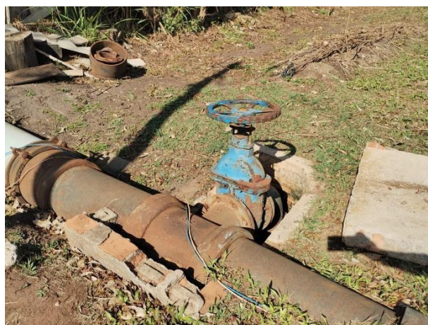
Figura 10 – Emissário região leste (chegada) e by-pass
