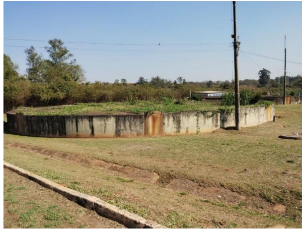
Figura 15 – Reatores UASB - Desativado
