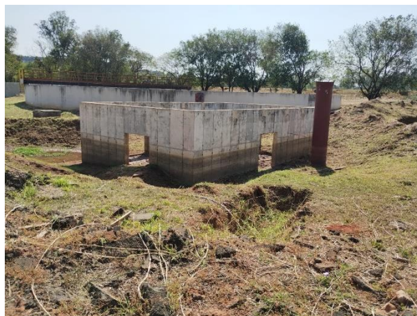
Figura 22 – Caixa de Registros - O dispositivo encontra-se parcialmente construído.
