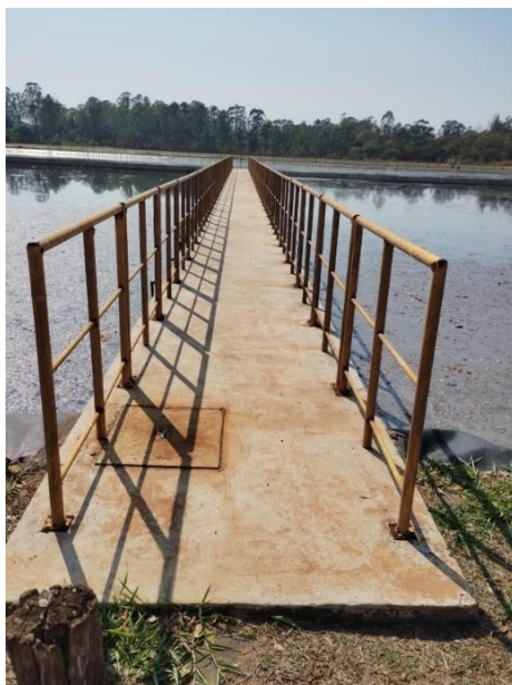
Figura 49 – Tanque de aeração - Passarela do tanque de aeração. Observa-se que os corrimãos estão sendo instalados.
