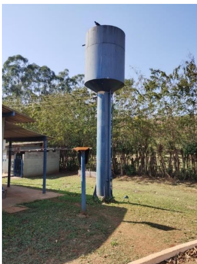
Figura 6 – Reservatório metálico tipo Taça para água potável
