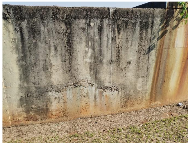
Figura 16 – Reatores UASB - Desativado
