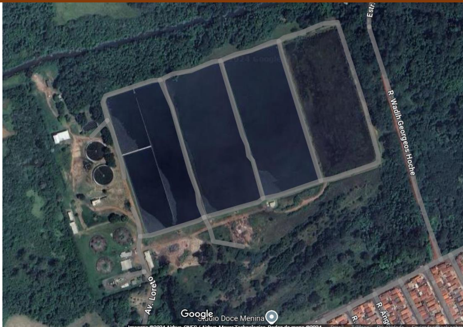
Figura 1 – Vista geral da ETE – Araras. (Fonte: Google Maps, 2024).
