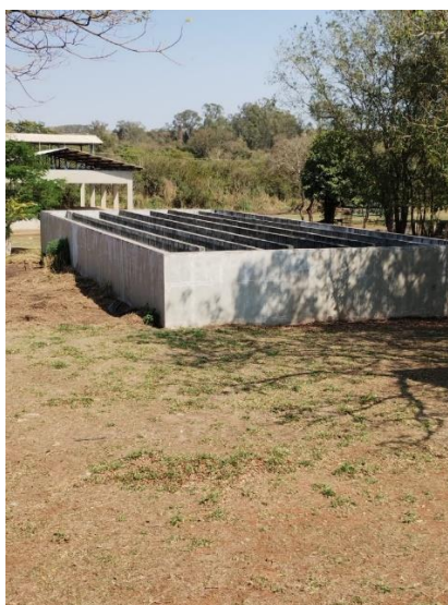
Figura 35 – Tanque de Desinfecção - Vista superior – observa-se a existência das chicanas.
