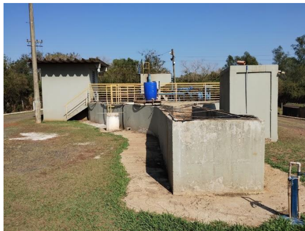
Figura 11 – Pré-tratamento – vista de jusante a montante
