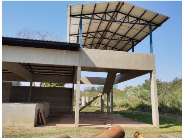
Figura 29 – Casa de desidratção do lodo - Vista dos fundos lado direito.
