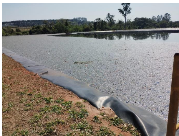
Figura 50 – Tanque de aeração - Vista da lateral à esquerda da passarela – observa-se que o tanque está sendo utilizado provisoriamente.
