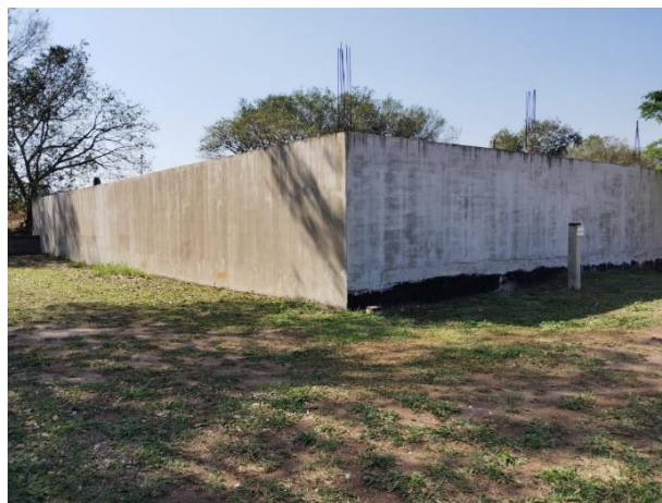
Figura 34 – Tanque de Desinfecção - Vista geral do dispositivo.
