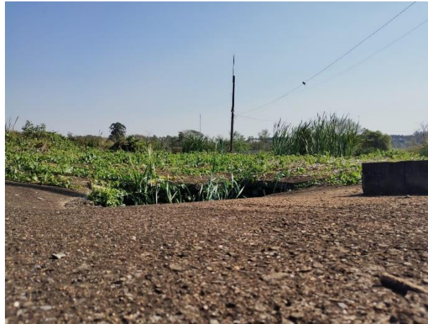
Figura 17 – Reatores UASB - Desativado
