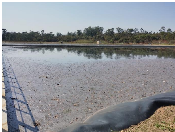
Figura 51 – Tanque de aeração - Vista da lateral à direita da passarela.
