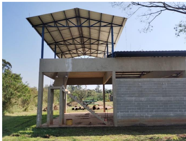
Figura 30 – Casa de desidratção do lodo - Vista dos fundos lado esquerdo.
