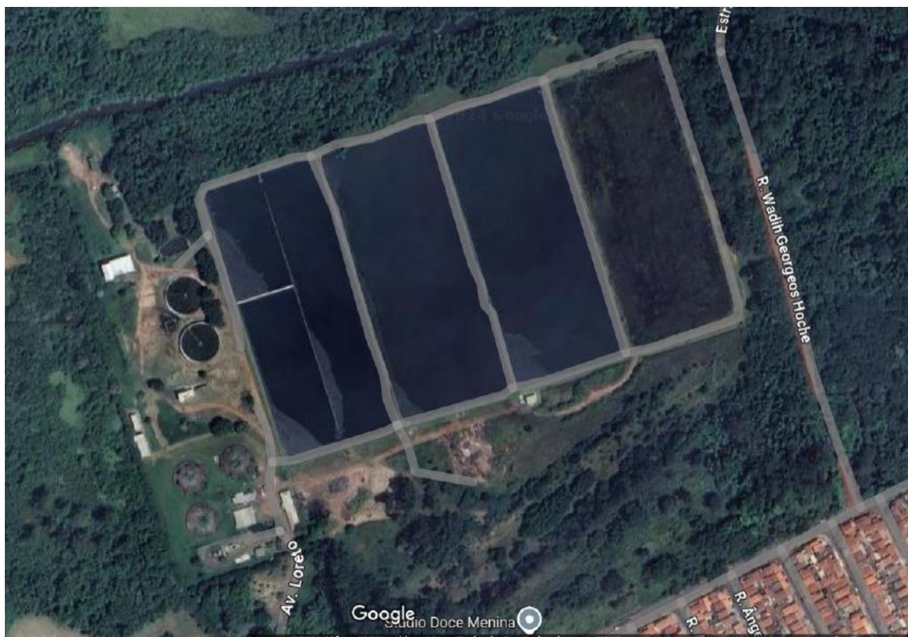
Imagem 1: Vista Geral da ETE – Araras (Fonte: Google Earth, 2024)
