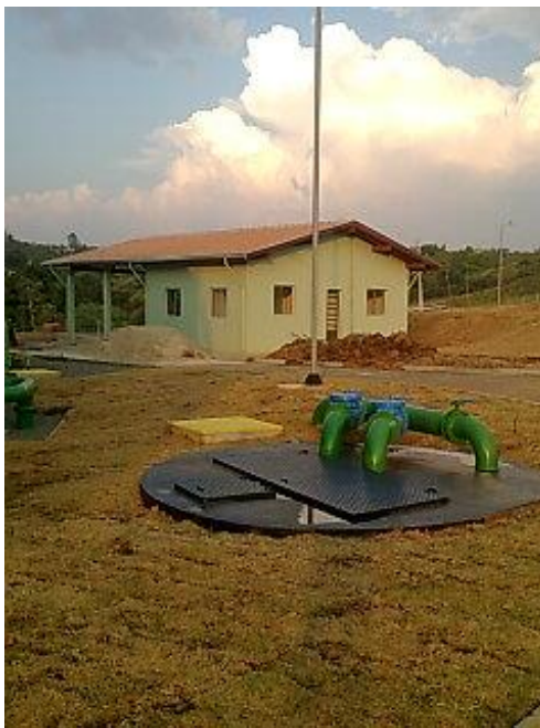
Figura 6. Modelo de Estação Elevatória de Esgoto (EEE) da Sanevix, constituído de 2 bombas.
