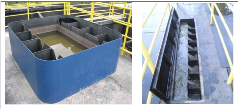
Figura 7. Cesto da caixa receptora de esgoto bruto e caixa de distribuição do esgoto modelo Sanevix.
