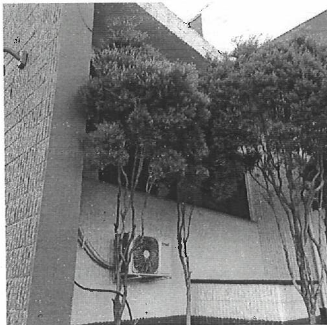
Foto 4- Descida dos condutores
