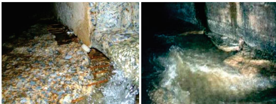
Figura 2. Galerias Córrego da Serra e Prudente de Moraes, respectivamente
