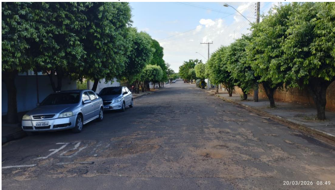
Foto 1- Trecho A- Rua Ceará (olhando da Rua Pernambuco para Avenida Brasil).
