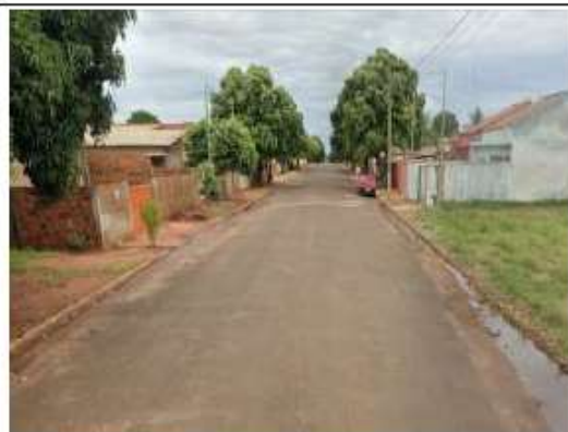
Figura 01: Local: Rua Dom Pedro II.
