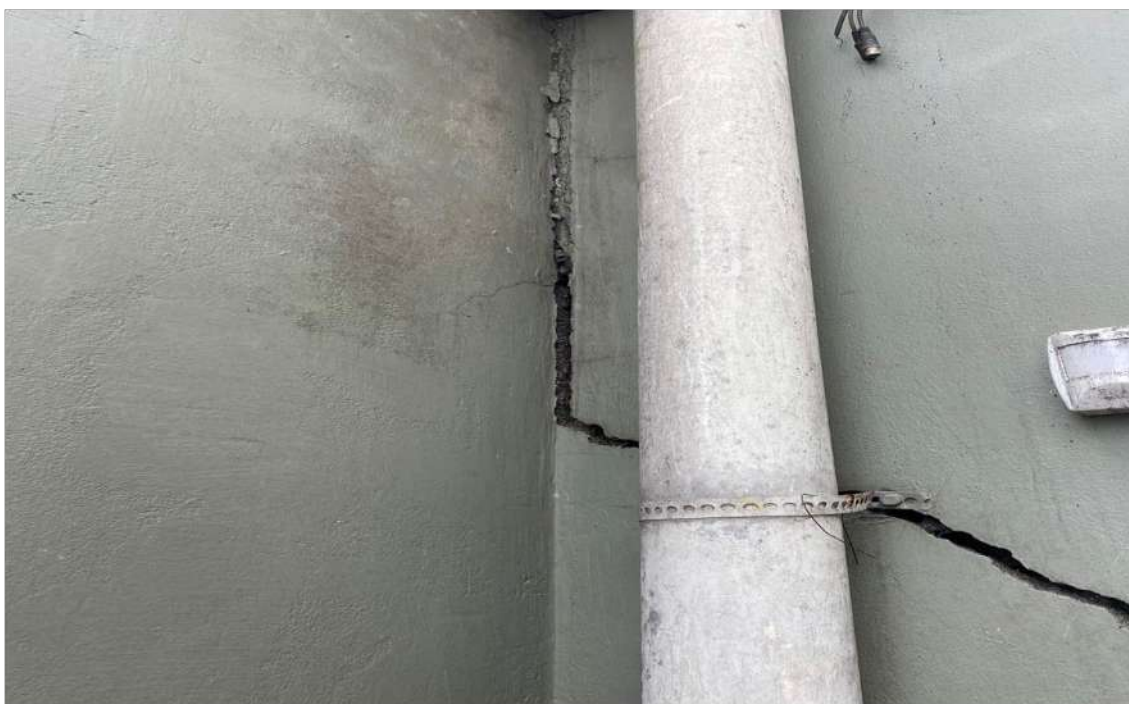
Fig.25 – Reparo estrutural (adm/muro verde).
