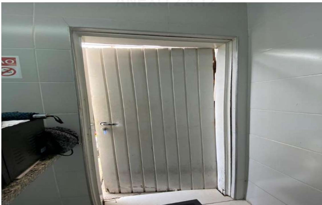
Fig.24 – Reparo estrutural, vão de porta. (copa/adm)
