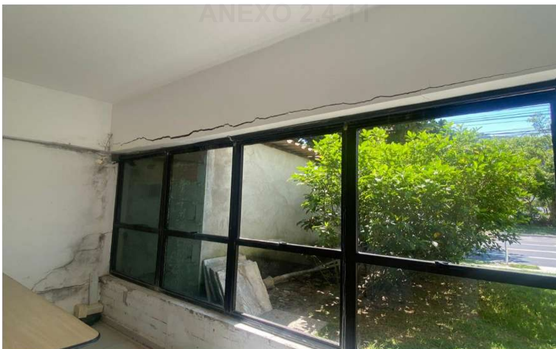
Fig.22 – Recuperação estrutural da viga existente (janela fundos/adm)
