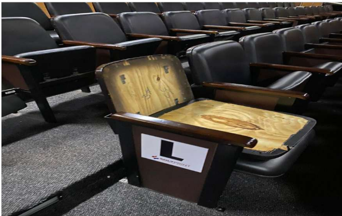
Fig.17 – Cadeiras auditório, encontram-se com assentos e encostos soltos.
