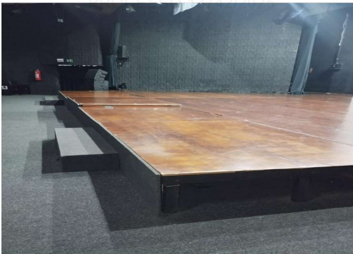
Fig. 18 – Remoção de base/assoalho, da rampa existente.
