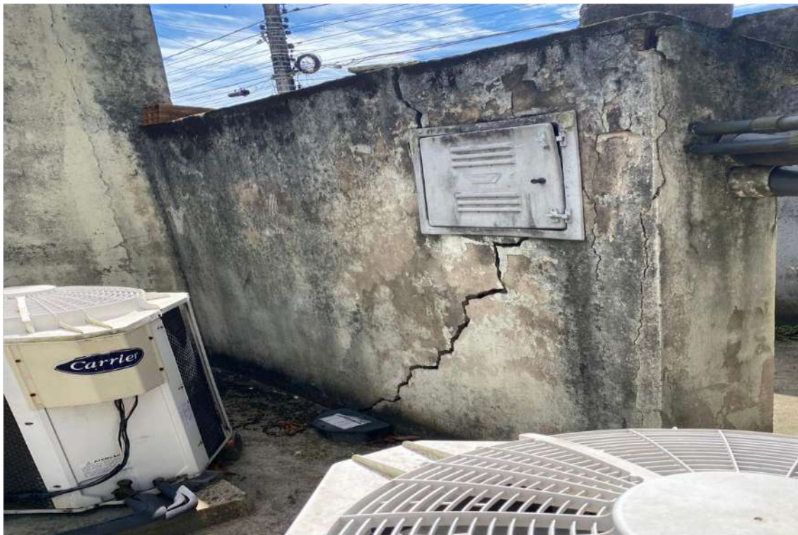
Fig.23 – Recuperação estrutural (quadro de luz/adm).
