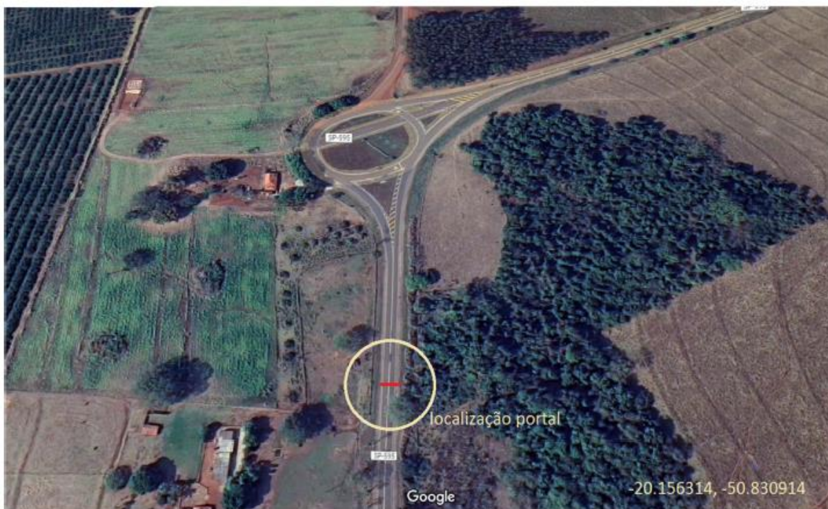
RAMAL DE ACESSO SP - 595
