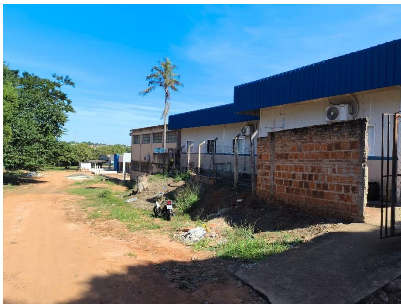
Foto 01 – Vista da entrada da Servidão de Acesso (lado direito) da Avenida da Saudade
