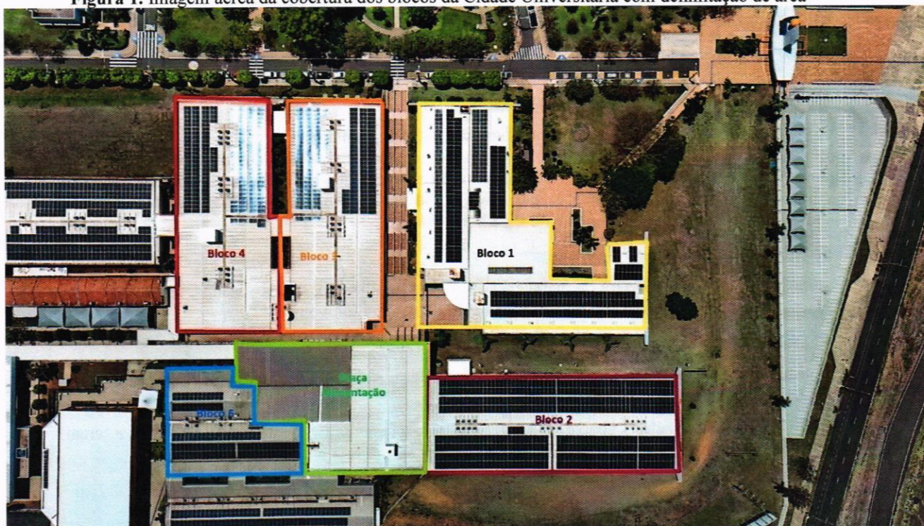
Figura 1. Imagem aérea da cobertura dos blocos da Cidade Universitária com delimitação de área
