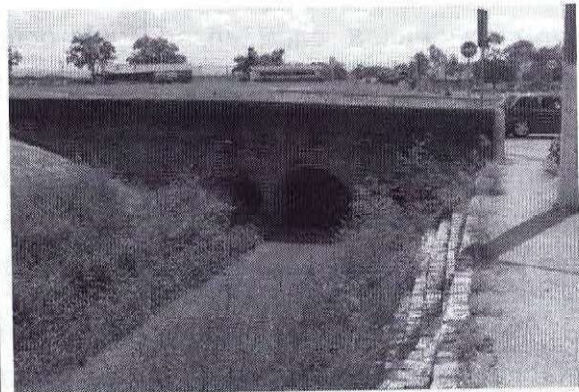
Figura 7: Vista Geral Da Travessia Sob a Avenida Roberto Lee.
