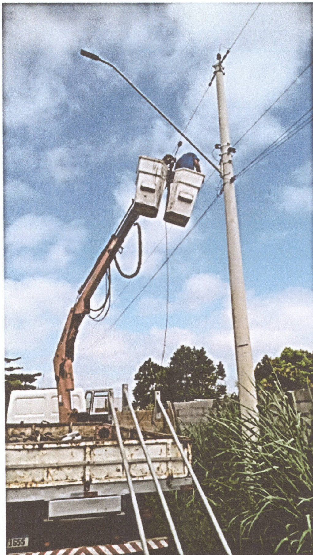
Instalação de braço com luminária relé e cabo
