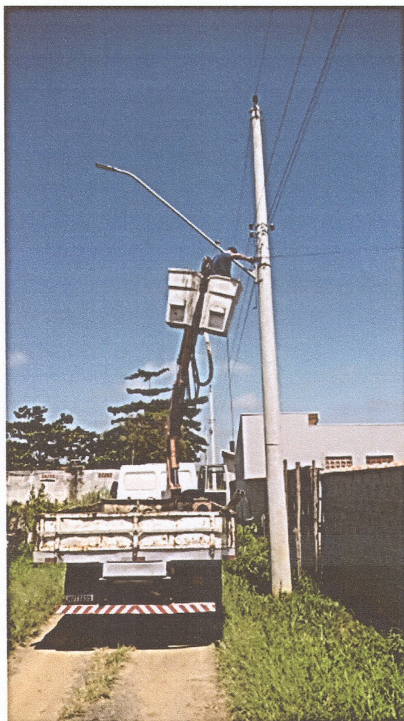
Instalação de braço com luminária relé e cabo rua projetada bairro Veloso
