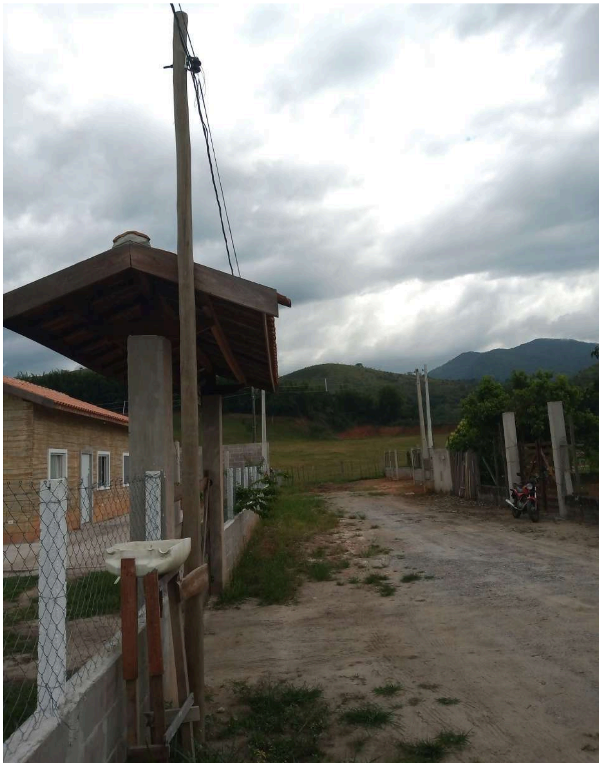
FIGURA 14 - Vista da última reta
