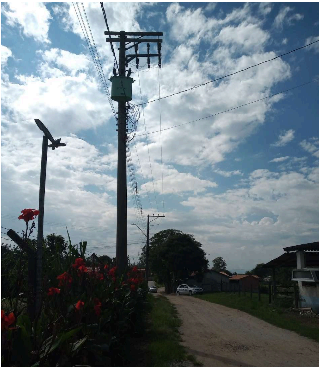
FIGURA 14 - Vista do outro lado da ET 504788
