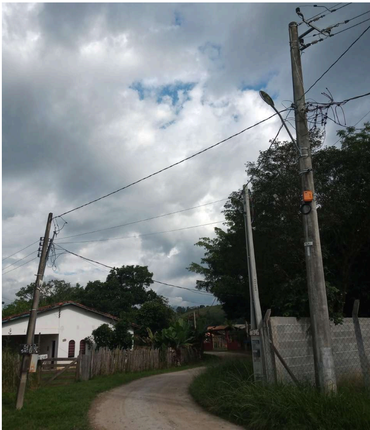
FIGURA 5 - Vista do começo da rua sem posteamento - local onde será instalado o transformador
