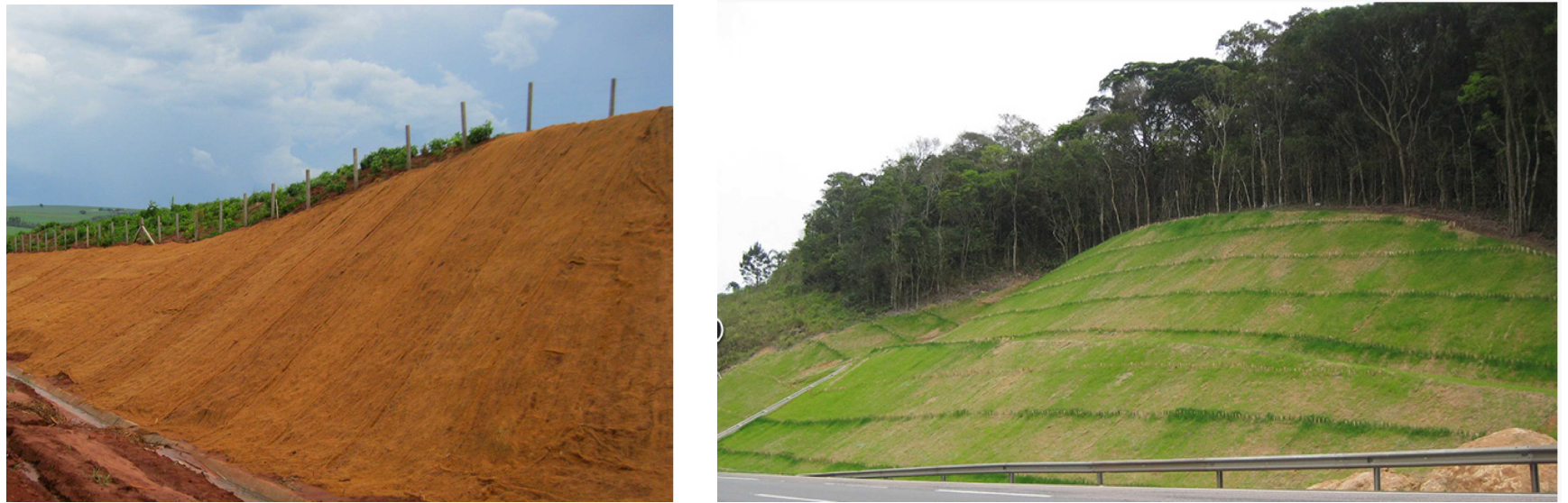
IMAGEM ILUSTRATIVA - BIOMANTA DE FIBRA DE COCO + HIDROSSEMEADURA SEM ESCALA Fonte: https://www.dprotecoes.com.br/producao/biomanta/
