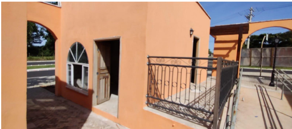
Foto 3: Vista das salas 03 e 04.
