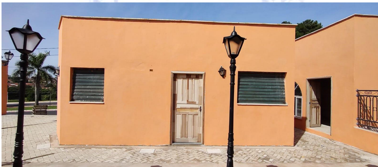
Foto 6: Vista da sala 08 e 09.
