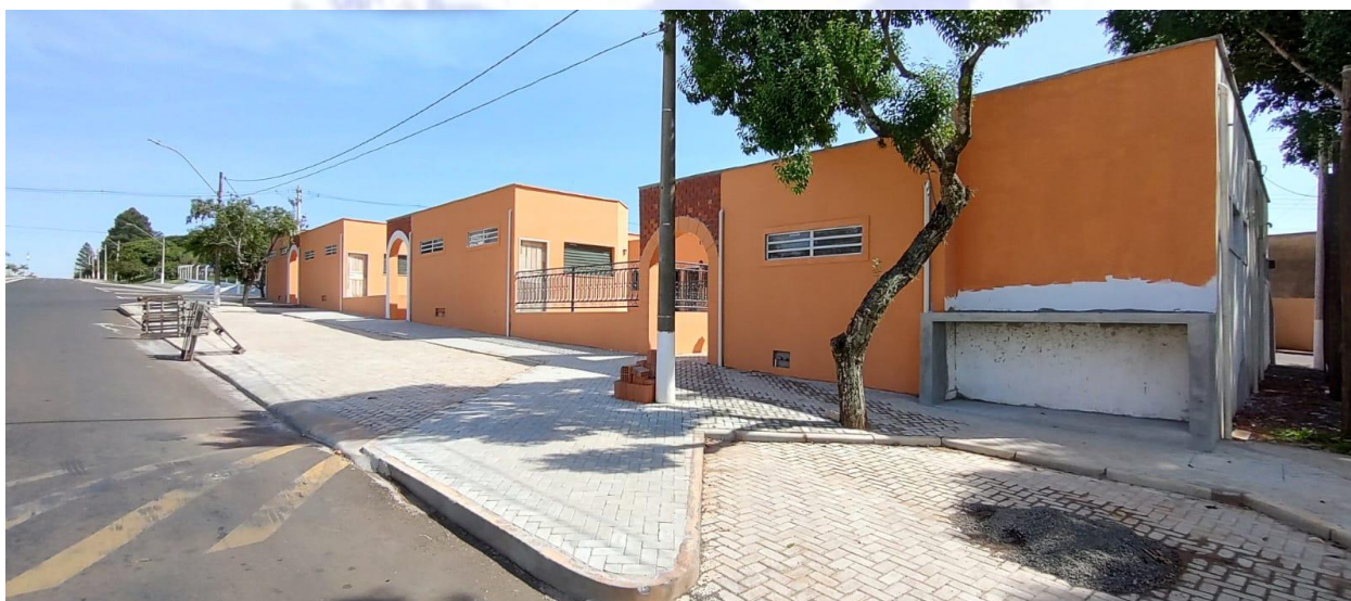
Foto 12: Vista lateral da Vila Gastronômica pela Avenida Luis Faulin Filho.
