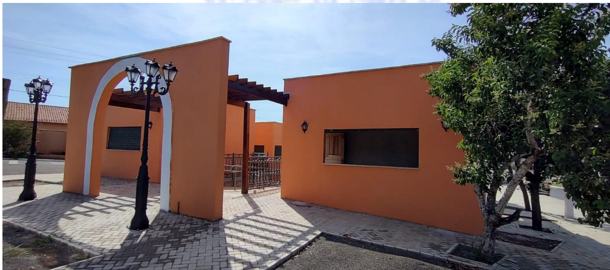
Foto1: Vista da fachada pela Avenida Helcy Bueno Faulin.
