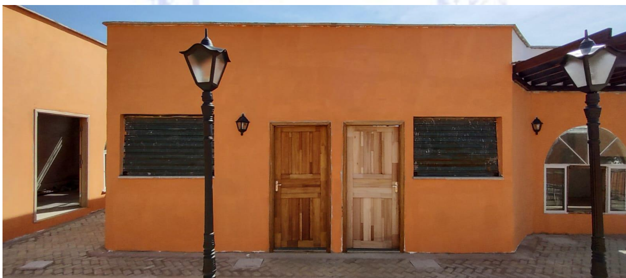
Foto 4: Vista das salas 05 e 06.
