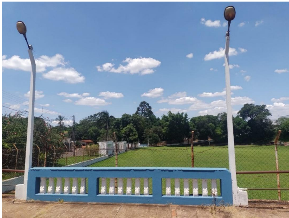
Figura 4 – Trecho tamponado do Córrego Lajeado Fonte: Secretaria de Agricultura e Meio Ambiente (2023)
