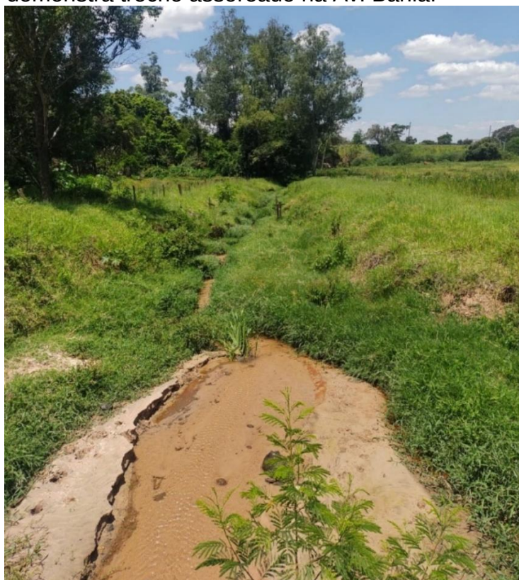
Figura 2 –Assoreamento em trecho do Córrego Lajeado Fonte: Secretaria de Agricultura e Meio Ambiente (2023)
