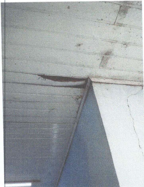
FOTO 01-FORRO PVC À SER EXECUTADO
