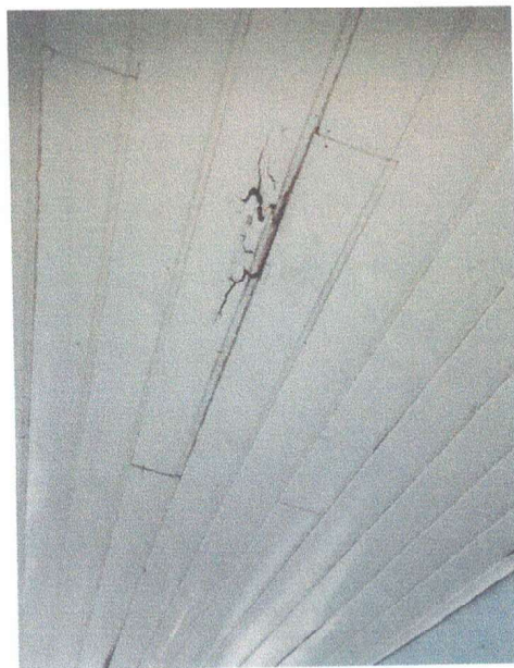
FOTO 02-FORRO PVC À SER EXECUTADO
