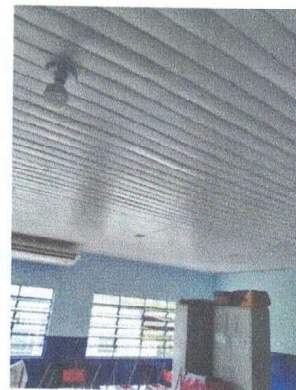
FOTO 12- FORRO PVC À SER SUPRIMIDO
