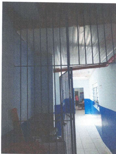
FOTO 08-FORRO PVC À SER EXECUTAD
