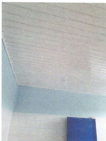
FOTO 07-FORRO PVC À SER EXECUTADO
