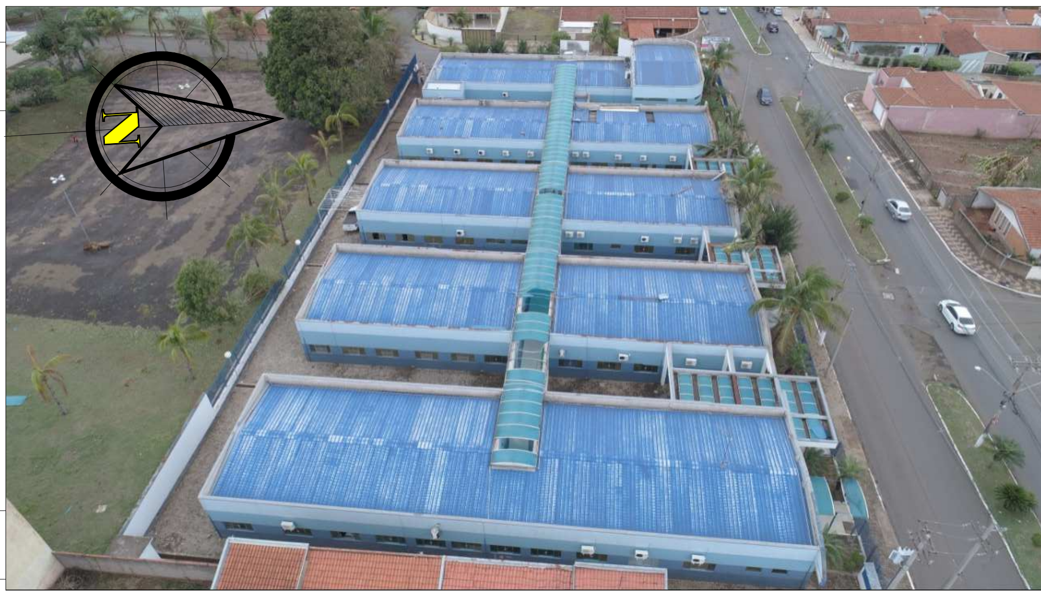
VISTA GERAL DO TELHADO sem escala
