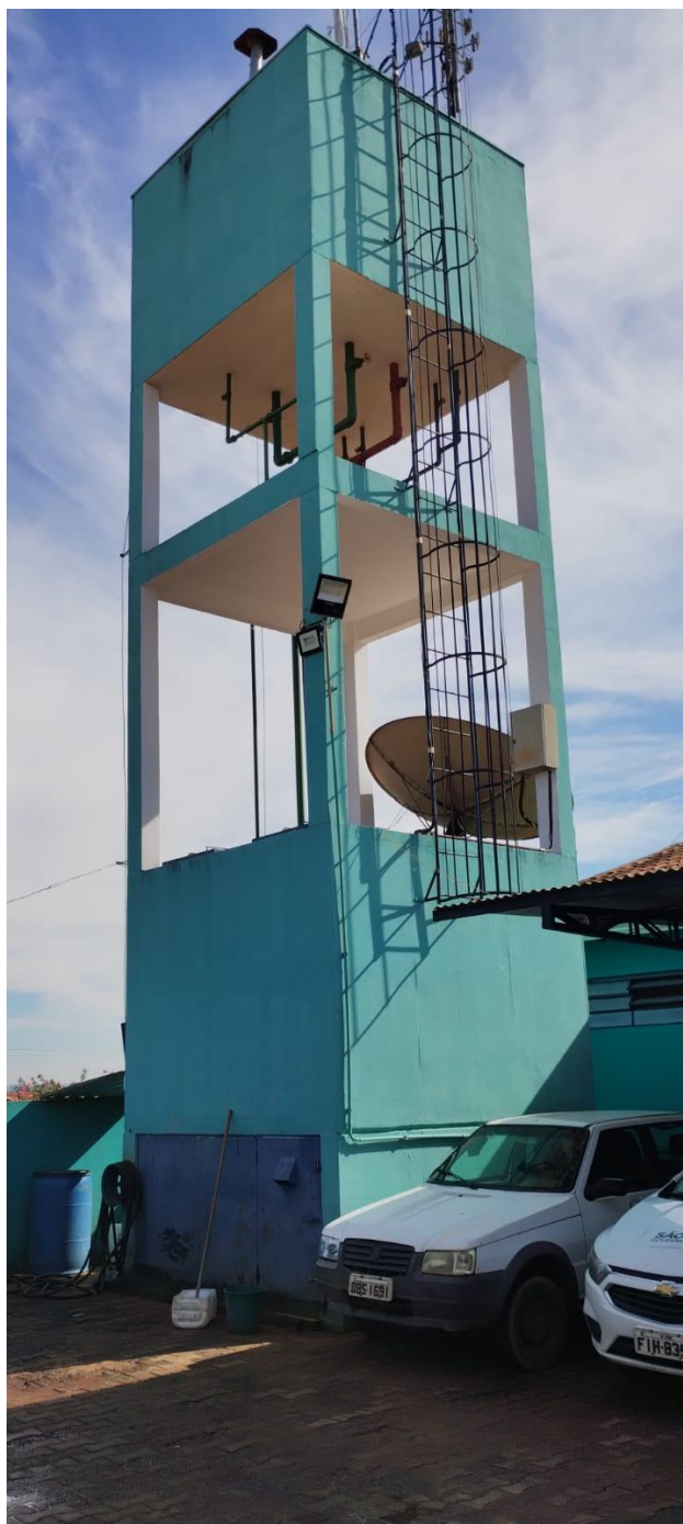
IMAGEM 05 – Caixa d'Água da Unidade de Saúde Alcibíades Pires, com tonalidade divergente da cor especificada.
