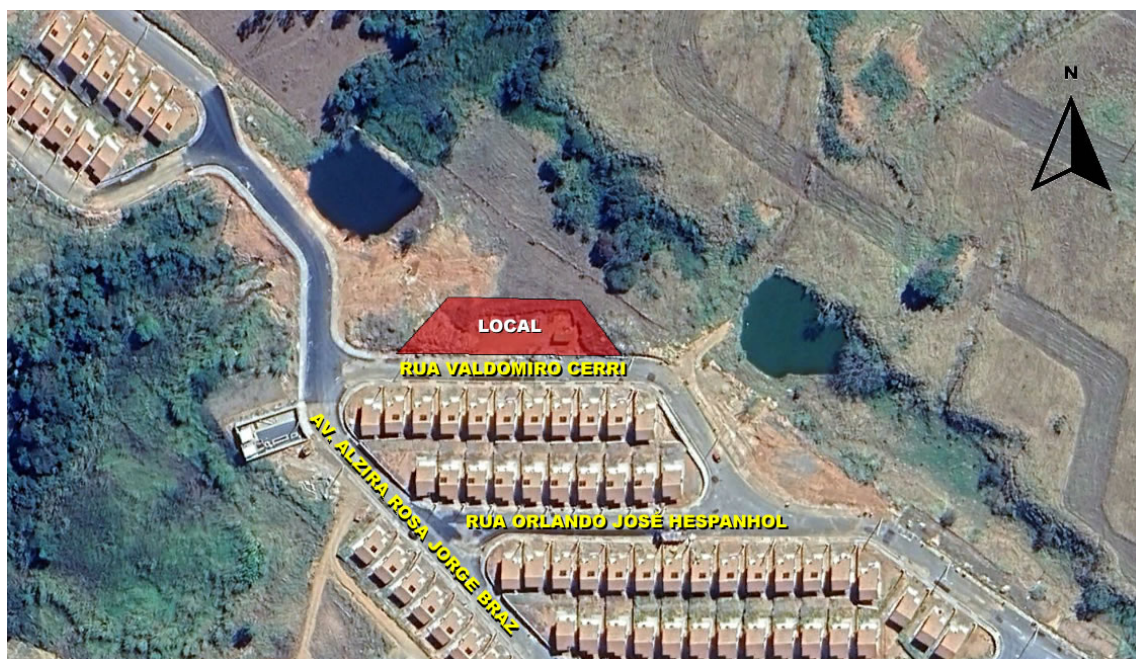
Figura 1 – Vista aérea do local da obra no bairro Jardim Nossa Senhora
