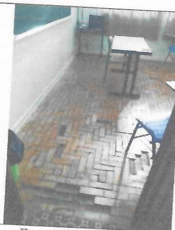
Foto 04 - Sala de aula
