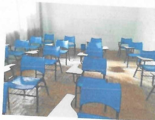
Foto 06 - Sala de aula
