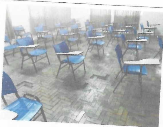
Foto 01 - Piso do auditório
