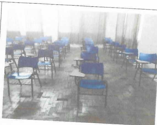
Foto 02 - Piso do auditório
